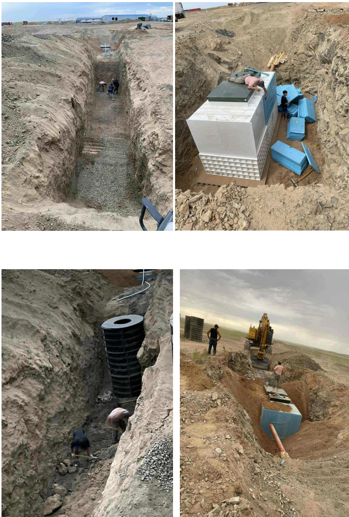
Зураг 8. Бохир ус цэвэрлэх байгууламж суурилуулж байгаа байдал
