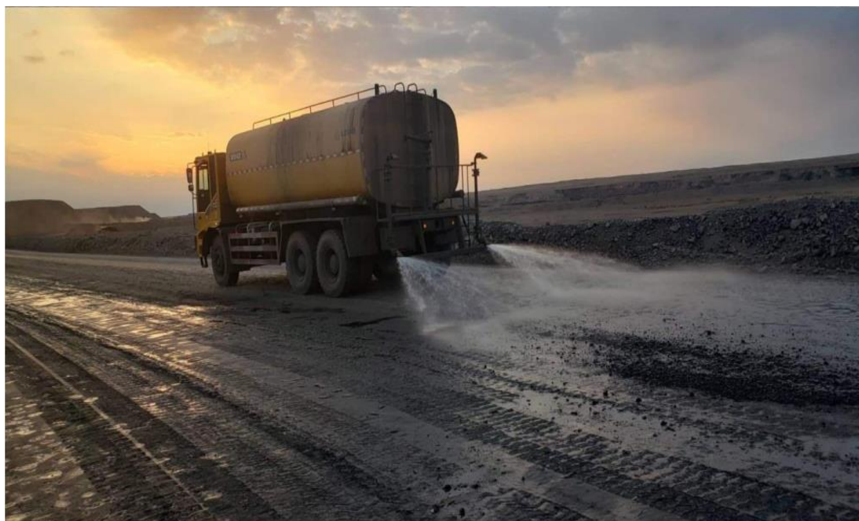
Зураг 2. Зам талбайд усалгаа хийгдэж байгаа байдал
