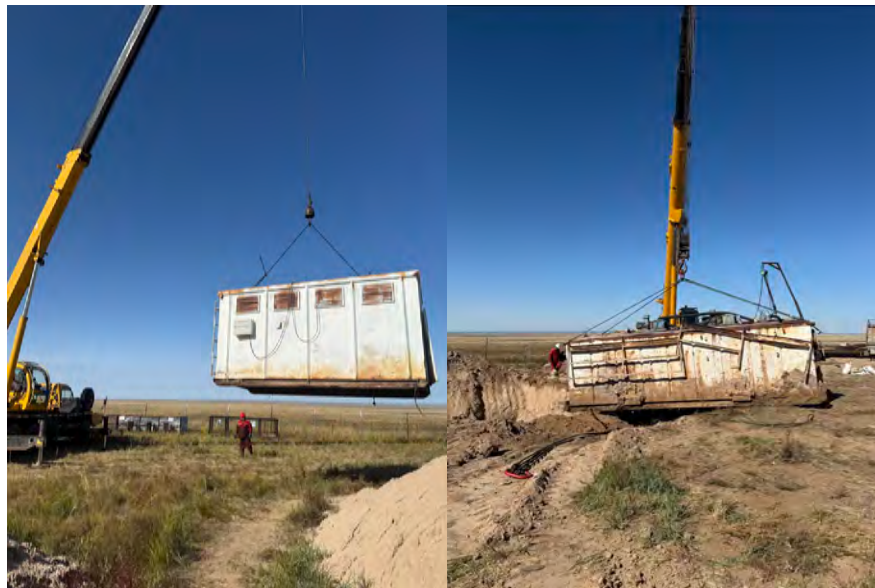
Зураг 31. Бохирын танкийг хөрснөөс авч буй байдал. /2025.09.26/
