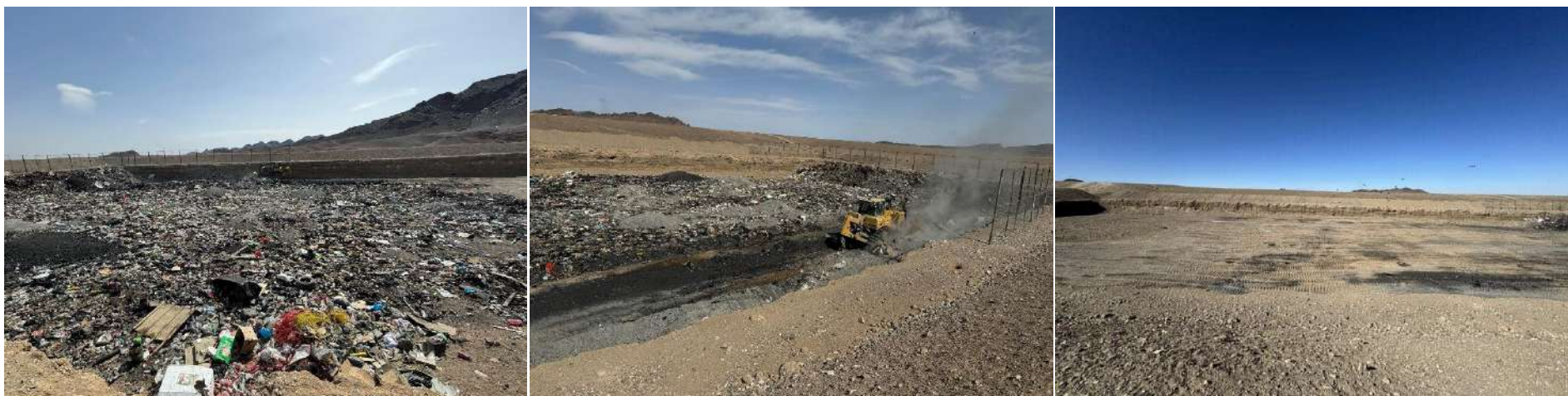
Зураг 49. Ноён сумын хог хаягдлын цэгийг түрж тэгшилэх ажлыг хийж гүйцэтгэлээ.
