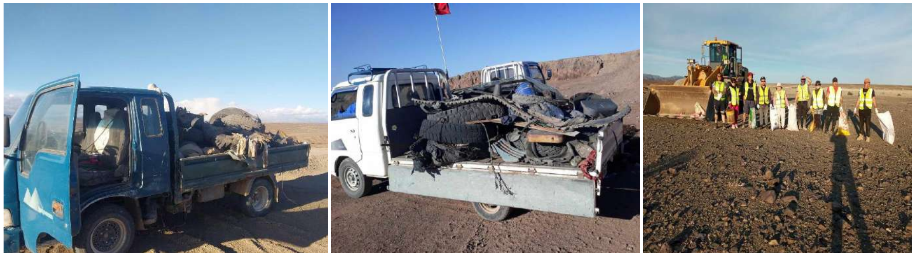
Зураг 55. Замын инженер нүүрс тээврийн зам дагуух хог хаягдлыг цэвэрлүүлсэн байдал /2025 2, 6 сар/
