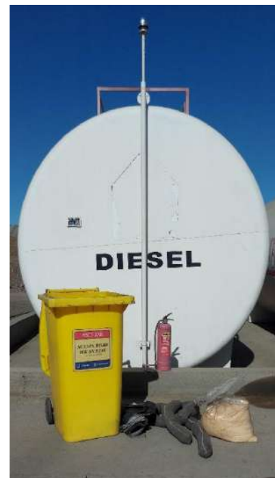
Зураг 11. Шатахуун түгээгүүр болон засварын газар асгаралтын иж бүрдлийг байршуулсан байдал
