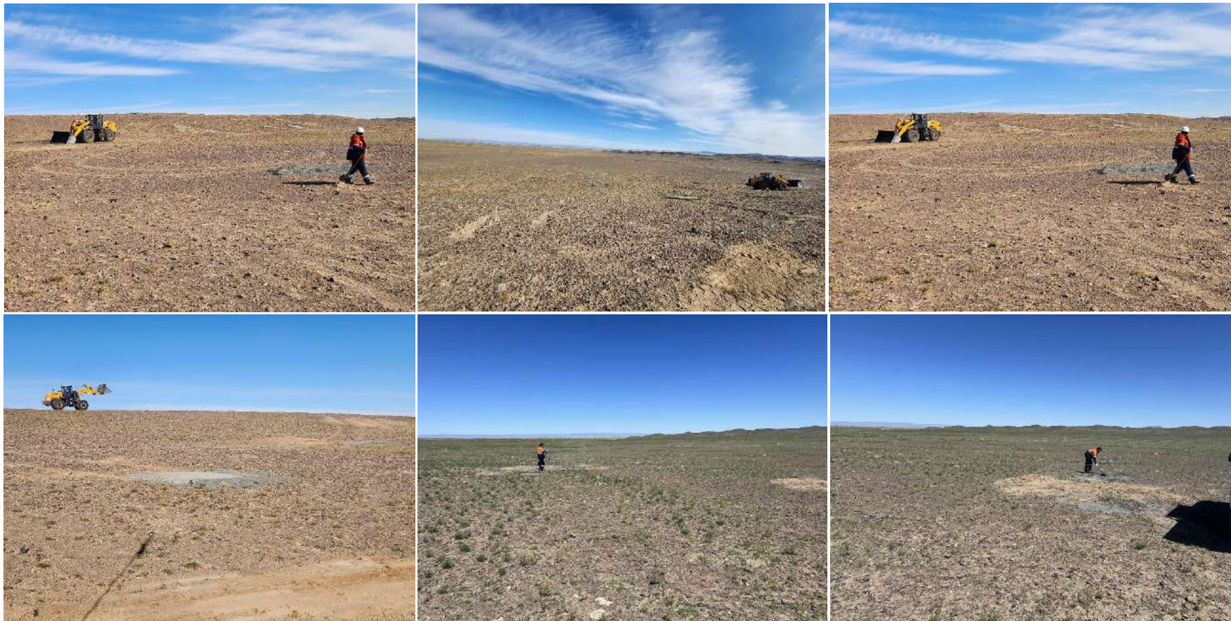
Зураг 19. Хайгуулын цооногуудыг техникийн нөхөн сэргээлт хийсний дараа гараар нарийвчлан тэгшилэх ажлыг гүйцэтгэж байна
