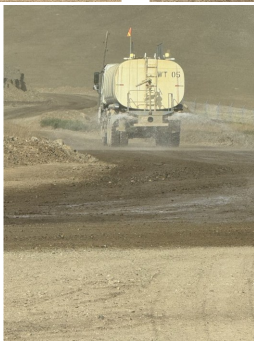
Зураг №-16 Замын усалгаа хийж буй байдал
