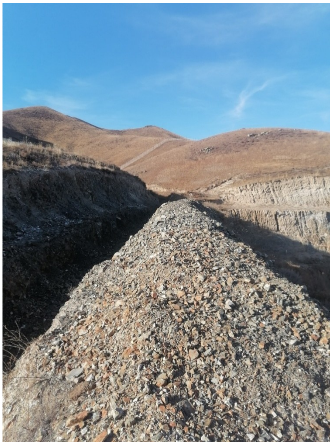
Зураг №-13 Ил уурхайг тойруулан үерийн далан татаж гар болзошгүй үер усны болон хүн-мал, амьтан унаж бэртэхээс сэргийсэн байдаг.
