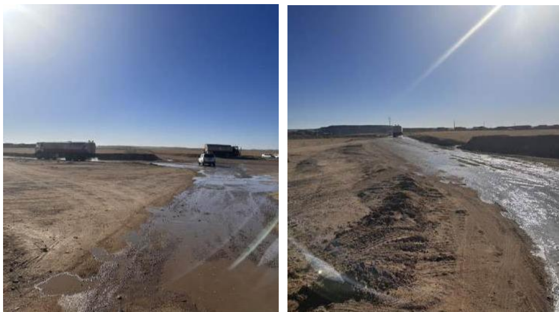
Зураг 2-8. Усалгаа хийж буй байдал
