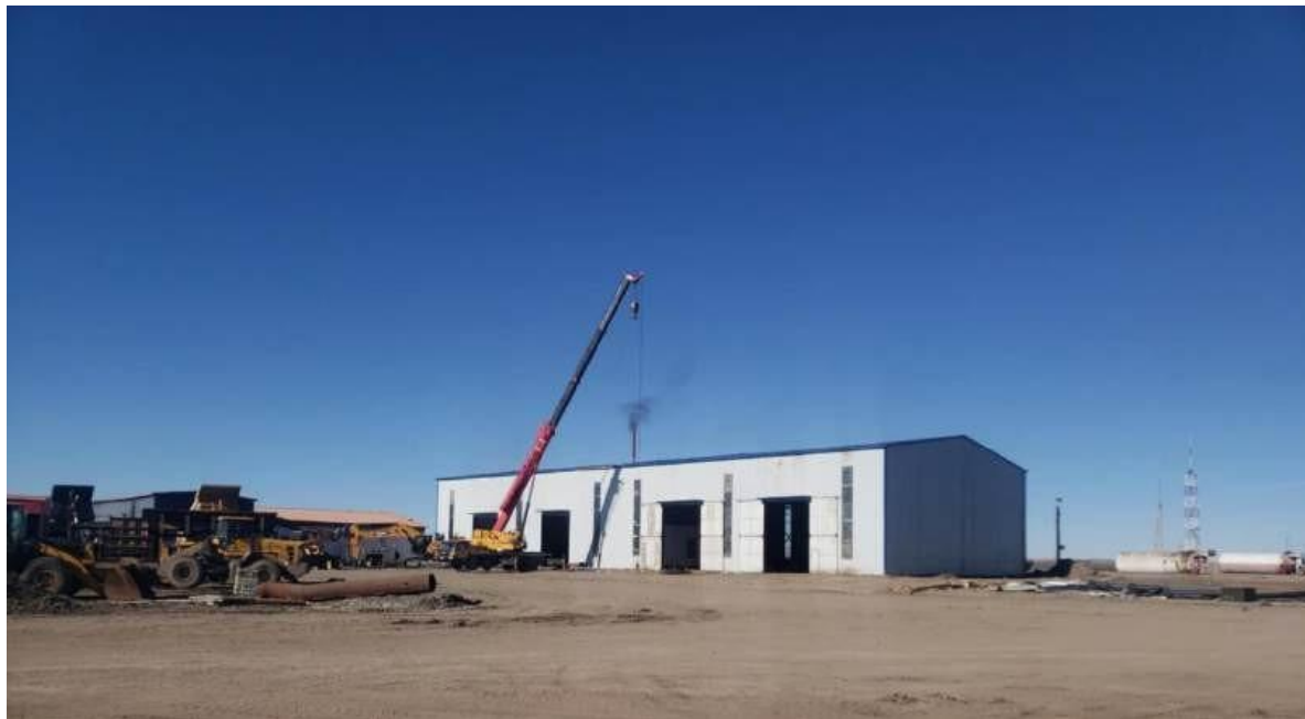
Зураг 2-10. Шинээр баригдаж буй засварын барилга
