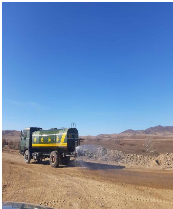
Зураг 2. Усалгаа хийж байгаа байдал
