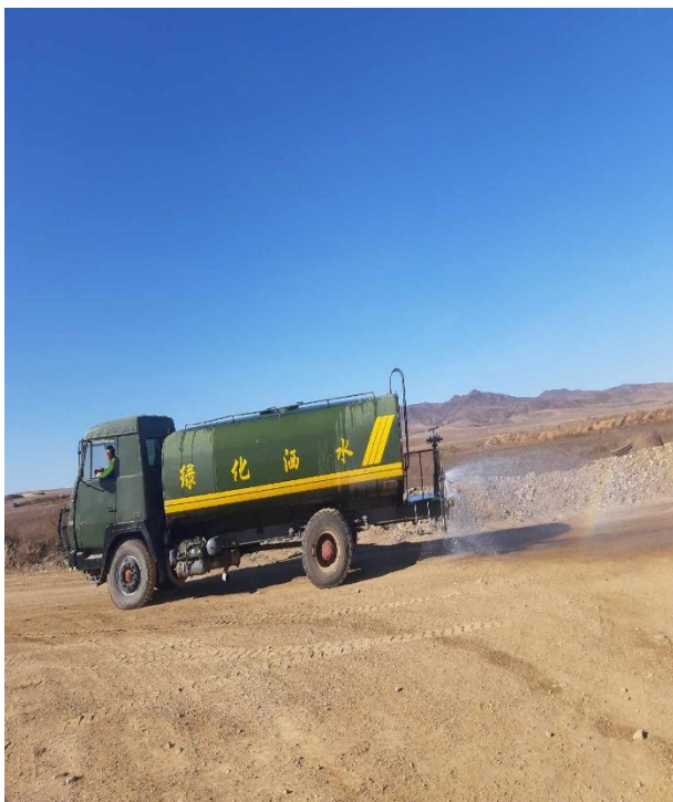
Зураг 2. Усалгаа хийж байгаа байдал
