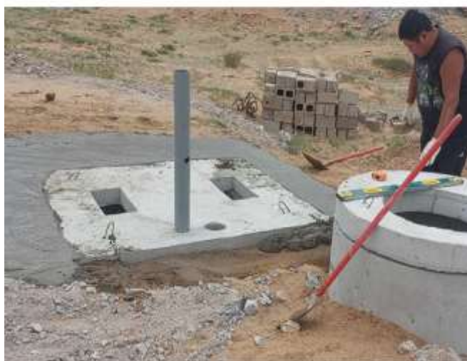
Зураг 15. Шинээр баригдаж буй ариун цэврийн байгууламж
