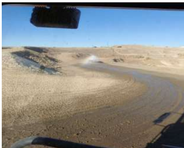
Зураг -1 зам усалж буй байдал
