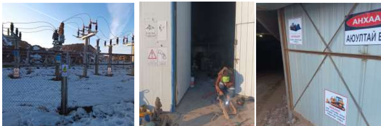
Зураг 18. ХАБ-н тэмдэг тэмдэглэгээ байршуулсан байдал
