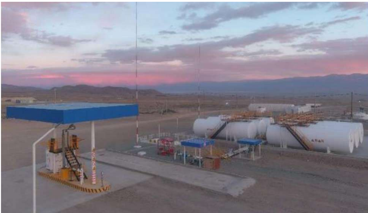
Зураг 14. Шатахуун түгээх станц
