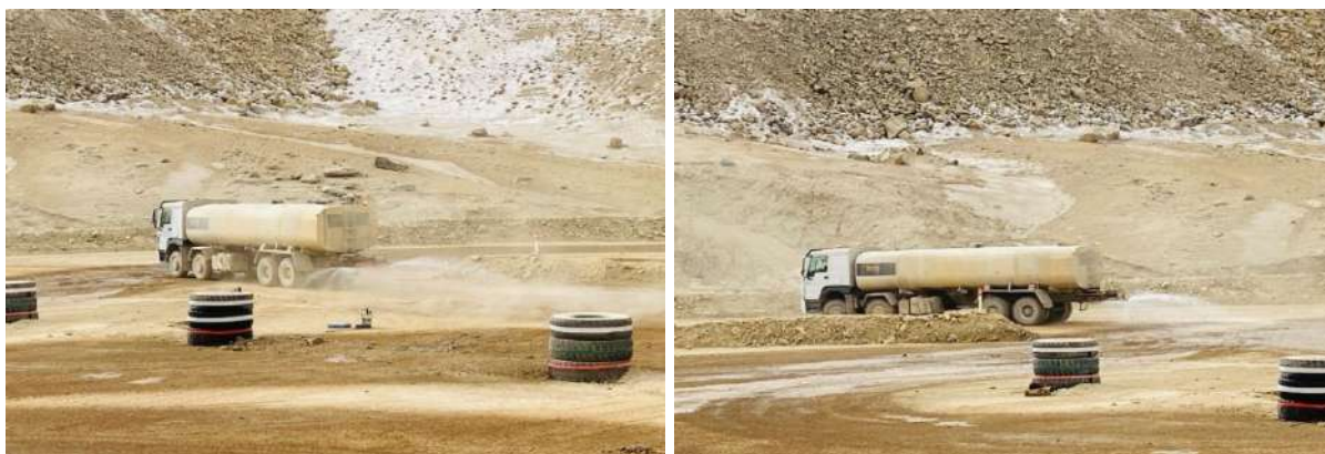
Зураг 2. Зам талбайн тоосжилт дарах усалгаа
