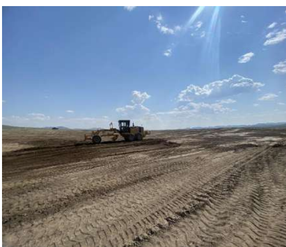
Зураг 9.Олон наст тарих талбайд дамн ковшоор шимт хөрс буулган D9R бульдозероор тарааж автогредеорээр тэгшилж буй байдал
