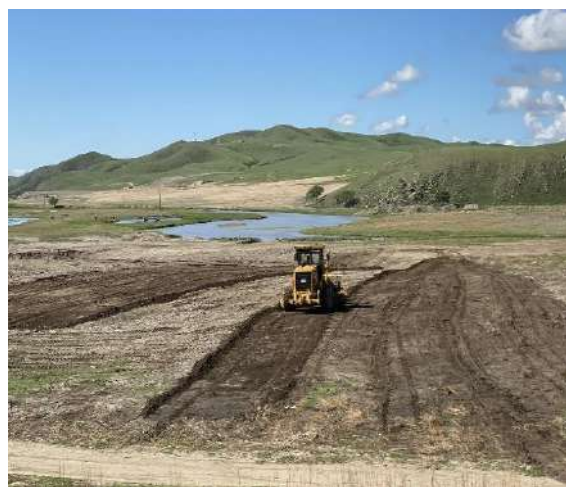
Зураг 9.Олон наст тарих талбайд дамн ковшоор шимт хөрс буулган D9R бульдозероор тарааж автогредеорээр тэгшилж буй байдал
