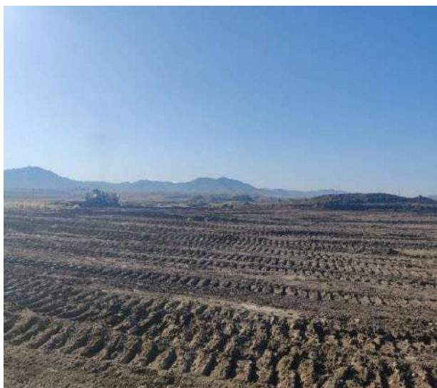
Зураг 8. Хөрс хуулалтын гадаад овоолгыг драгийн олборлолт явагдсан мөрөгцөгийн орон зайг дүүргэн Катерпиллер D9R, 2 ширхэг бульдозеруудаар тэгшлэн автогрейдерээр өнгөлгөө хийж буй байдал
