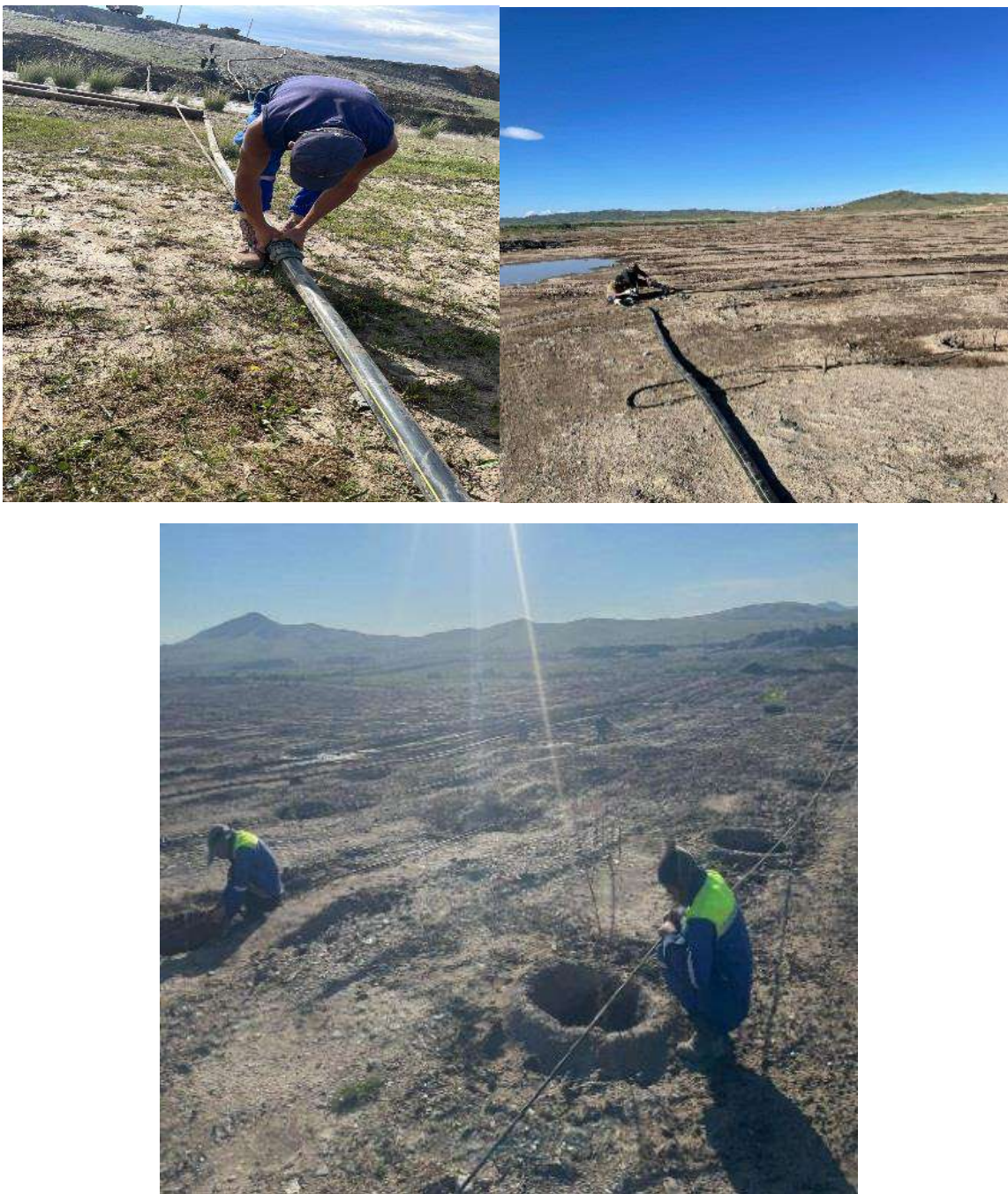
Зураг 25. Ойжуулалт хийсэн талбай дээр усалгааны систем угсарч буй байдал
