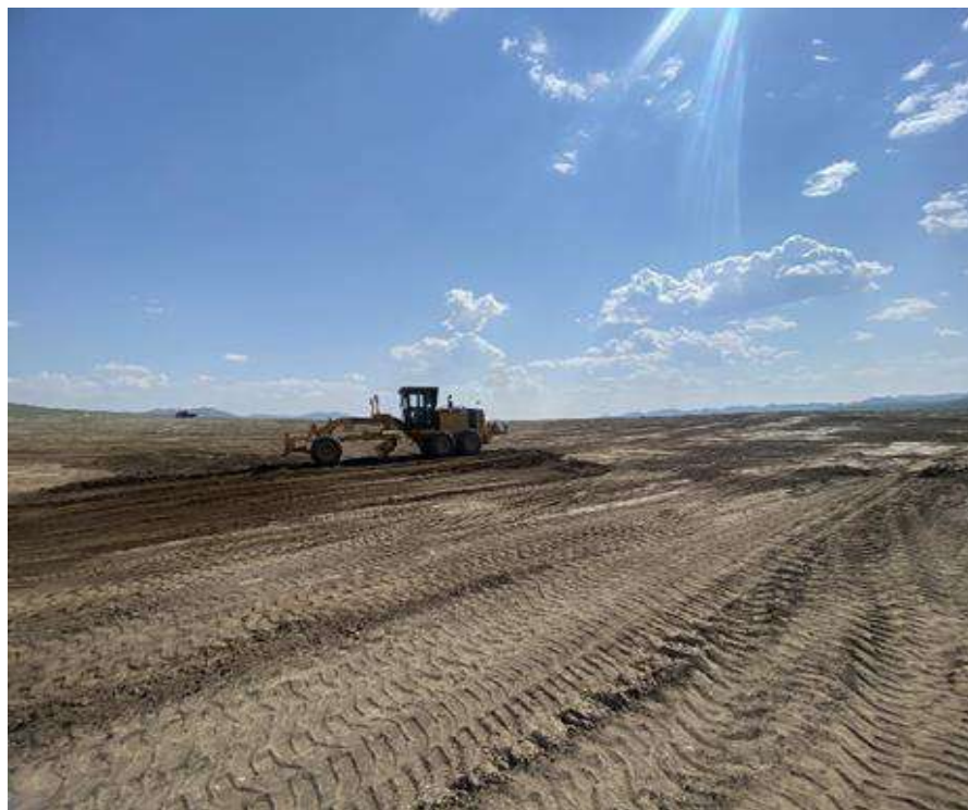
Зураг 10. Автогрейдерээр тэгшилж буй байдал
