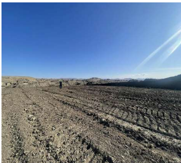
Зураг 8. Хөрс хуулалтын гадаад овоолгыг драгийн олборлолт явагдсан мөрөгцөгийн орон зайг дүүргэн Катерпиллер D9R, 2 ширхэг бульдозеруудаар тэгшлэн автогрейдерээр өнгөлгөө хийж буй байдал
