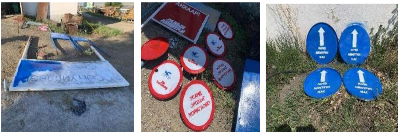
Зураг 31. Хуучирч, элэгдсэн, будаг нь бүдгэрсэн, эвдэрч хаягдсан тэмдэг тэмдэглэгээнүүдийг цуглуулж, засварлаж, шинэчлэн будаж, шаардлагатай байгаа тэмдэг болгон цоолборложбудсан, байрлуулахад бэлэн болсон тэмдэгнүүдийн байдал.
