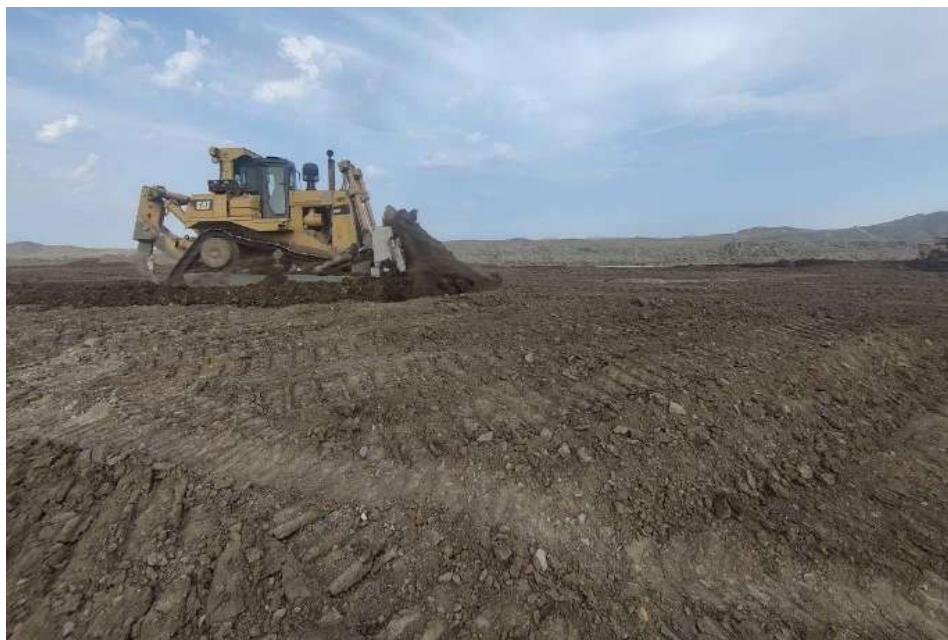
Зураг 8.. Бульдозероор хэлбэржүүлэн тэгшилж автогрейдерээр өнгөлгөө хийж буй байдал
