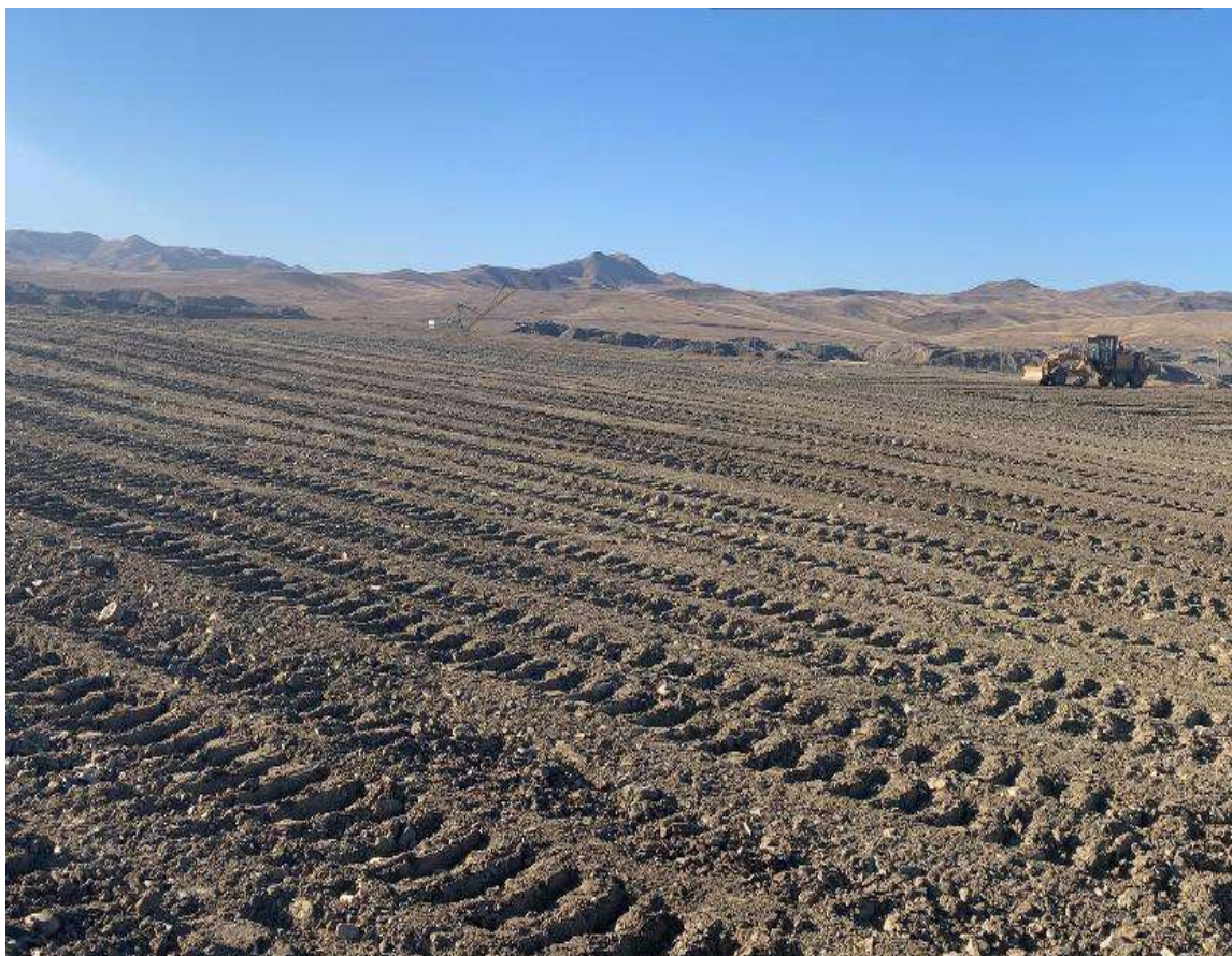
Зураг 8. Хөрс хуулалтын гадаад овоолгыг драгийн олборлолт явагдсан мөрөгцөгийн орон зайг дүүргэн Катерпиллер D9R, 2 ширхэг бульдозеруудаар тэгшлэн автогрейдерээр өнгөлгөө хийж буй байдал.
