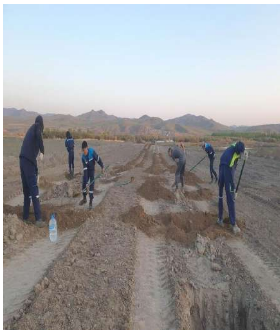
Зураг 12. Шимт хөрс ковшоор тарааж модны тогоо бэлдэж буй байдал
