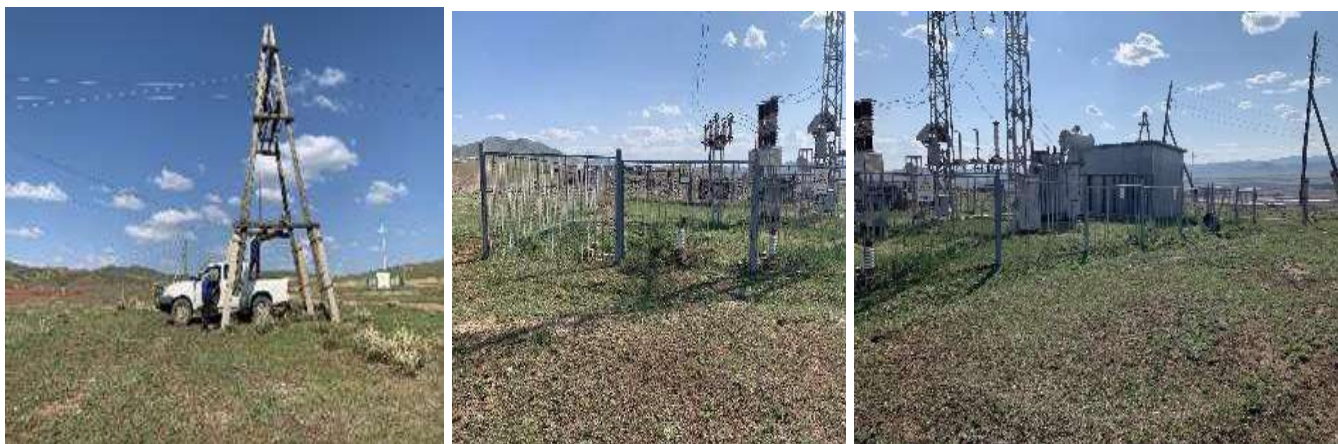
Зураг 30. Уурхайн урд, хойд 35 кВ-ын цахилгааны дэд станцуудад, төлөвлөгөөт үзлэг, засвар хийж буй байдалд хяналт тавьж, цахилгаан хүчдэлд нэрвэгдэх эрсдэлийг бууруулахад анхаарал тавьж ажилласан.
