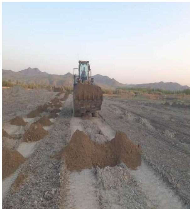
Зураг 12. Шимт хөрс ковшоор тарааж модны тогоо бэлдэж буй байдал
