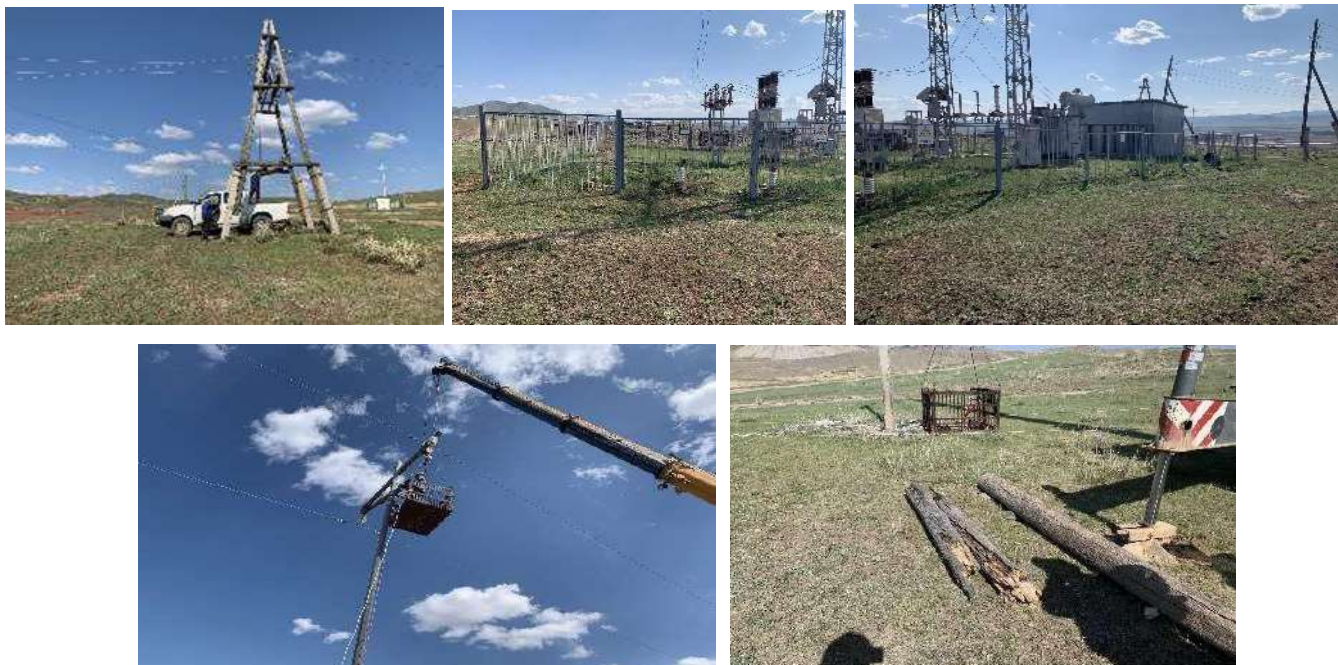
Зураг 34. Уурхайн урд, хойд 35 кВ-ын цахилгааны дэд станцуудад, төлөвлөгөөт үзлэг, засвар хийж буй байдалд хяналт тавьж, цахилгаан хүчдэлд нэрвэгдэх эрсдэлийг бууруулахад анхаарал тавьж ажилласан.
