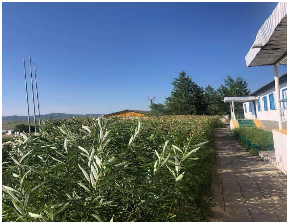
Зураг 15. Ногоон байгууламжийн ажлууд хийгдэж буй байдал
