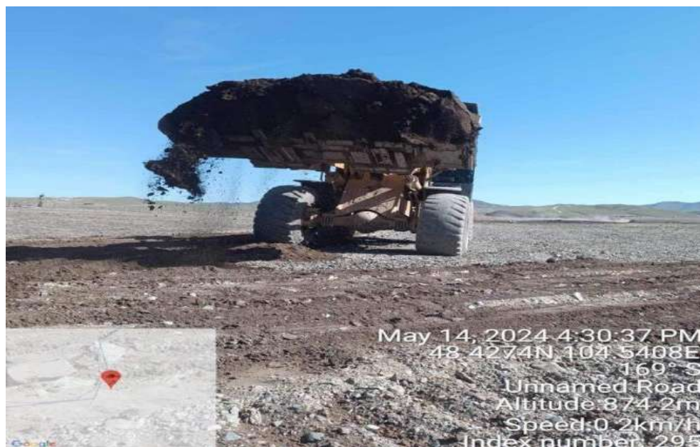
Зураг 9. Дамп ковшиор шимт хөрс буулган D9R бульдозероор тарааж буй байдал
