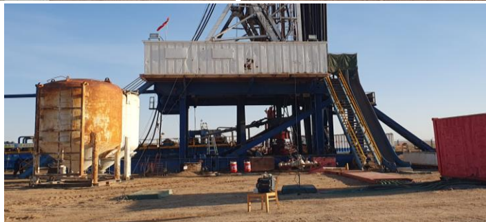
Зураг 28. Өгөөмөрийн хотгорын орчны хяналт шинжилгээний ажил
