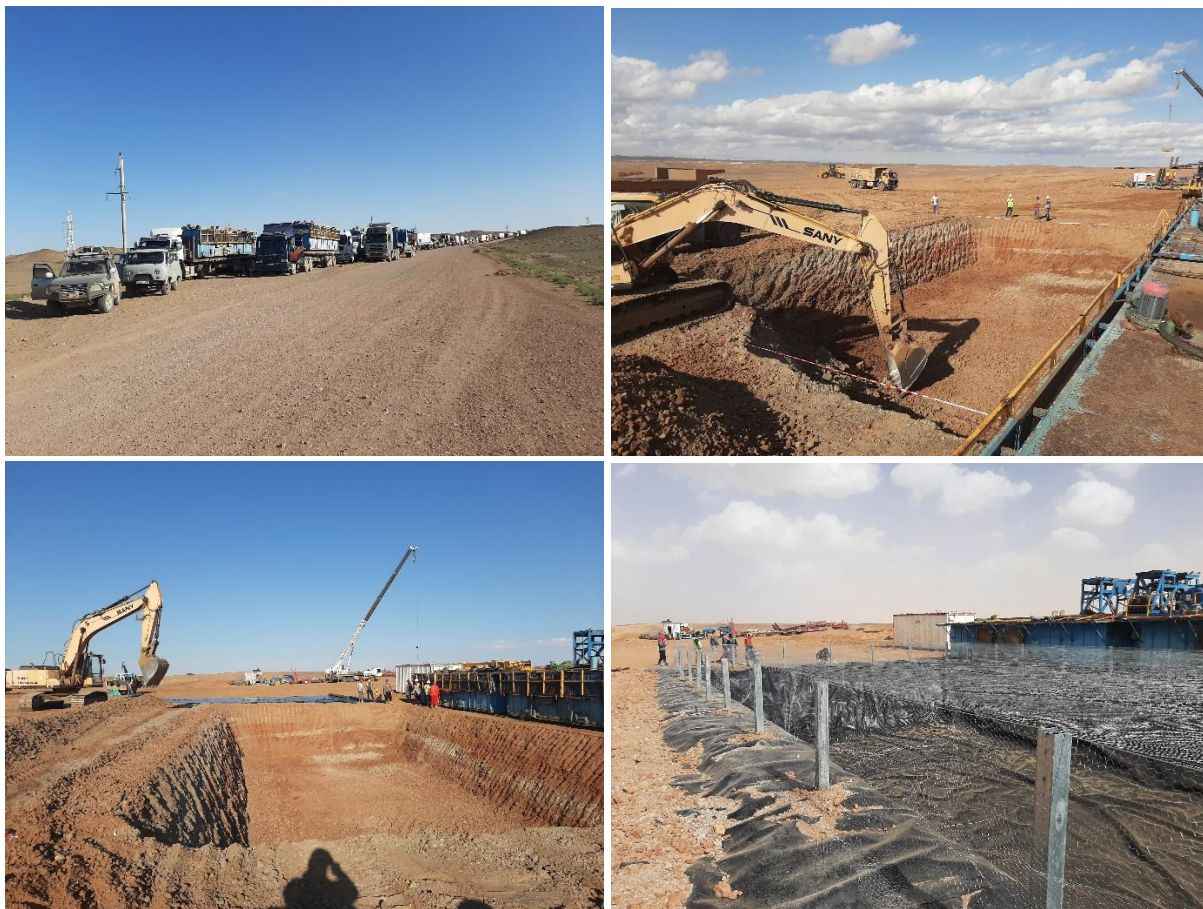
Зураг 13. Өрмийн тоног төхөөрөмжийн тээвэр болон шингэн хаягдлын сангийн доторлогоо
