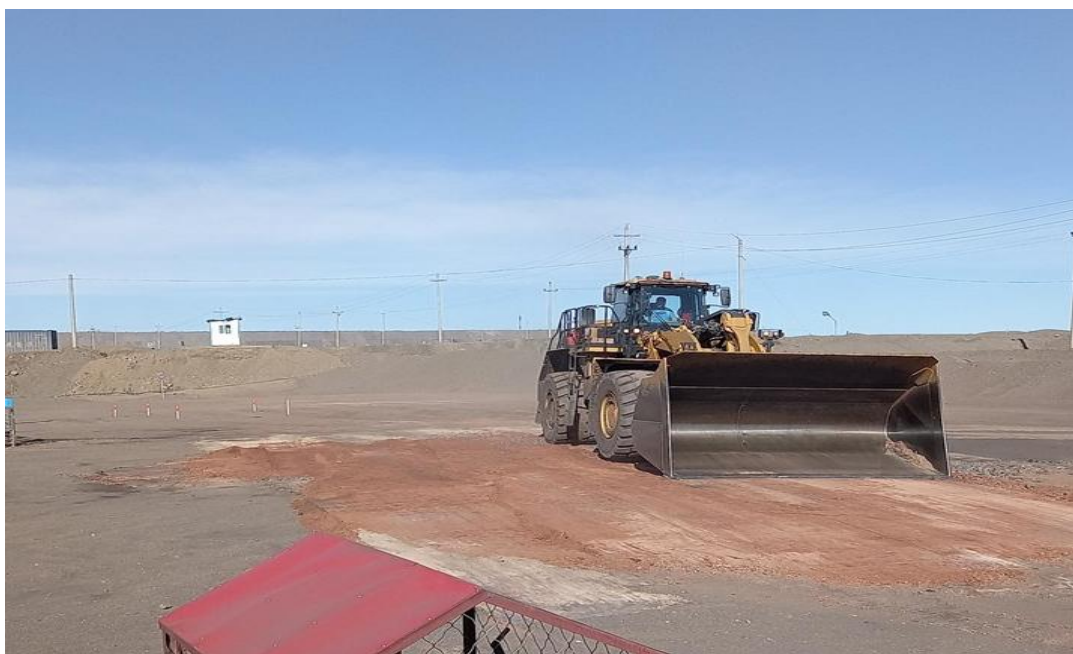
Зураг 41. Ажлын талбайд техникийн нөхөн сэргээлт, тэгшилгээ хийж байгаа байдал
