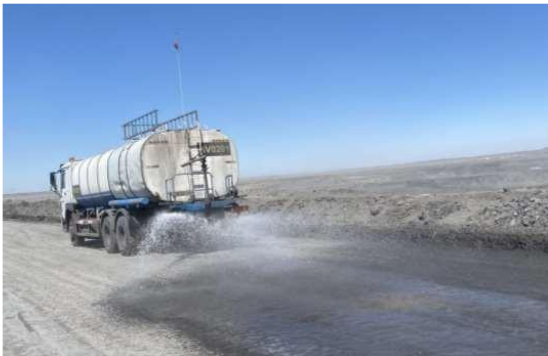
Зураг 16. Зам талбайн тоос дарах усалгаа хийж буй байдал
