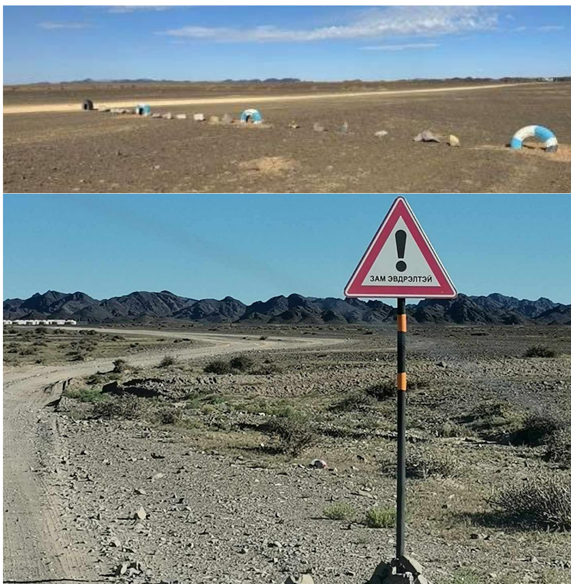
Зураг 26. Замын тэмдэг байршуулж, хаалт хашилт хийсэн байдал
