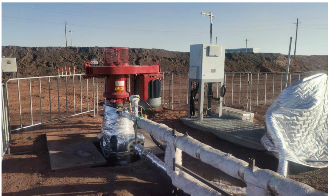
Зураг 40. Туршилт олборлолтын цооногийн амсарыг битүүмжилсэн байдал
