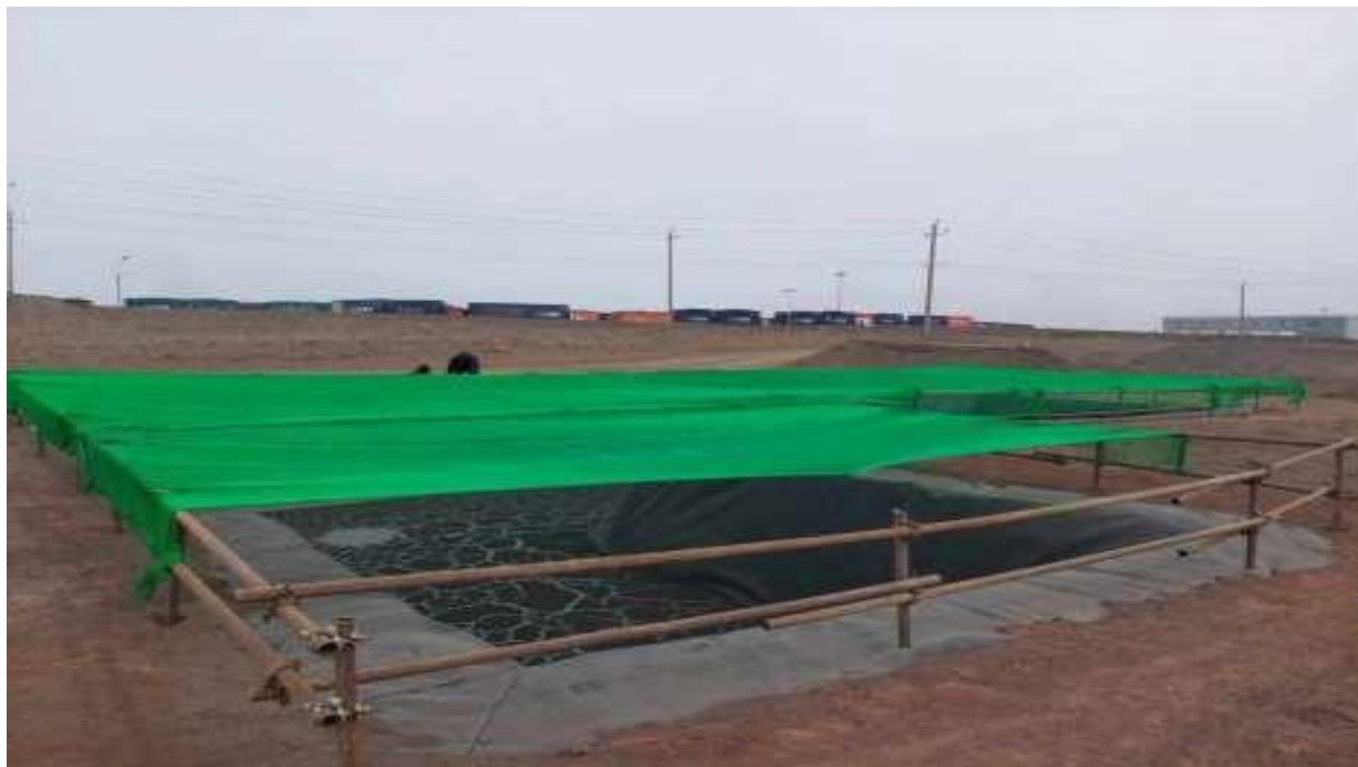
Зураг 22. Өрөмдлөгийн нүхэнд шувуу орохоос хамгаалсан тор хийсэн байдал
