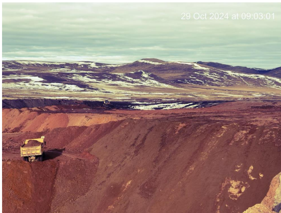
Зураг № 26 Дотоод овоолгоор техникийн нөхөн сэргээлт хийж буй байдал
