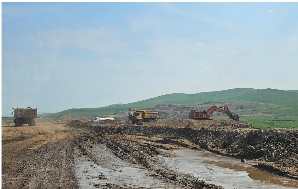
Зураг № 6 Зам усалгааны ажил хийгдэж буй байдал
