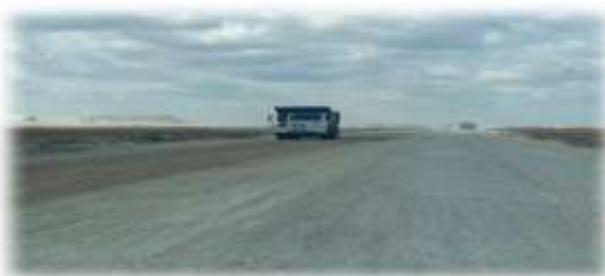
Зураг 12. Уурхайн дотоод тээврийн замд дэвсэлт болон усалгаа хийгдсэн байдал
