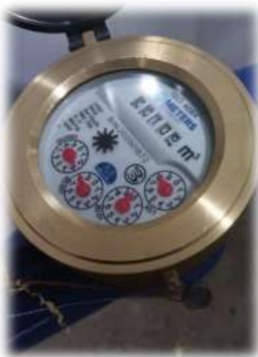
Зураг 40. Ундны усыг хангаж буй гүний худгийн эх үүсвэрт тоолууржуулсан байдал
