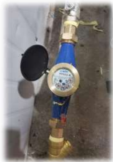
Зураг 40. Ундны усыг хангаж буй гүний худгийн эх үүсвэрт тоолууржуулсан байдал
