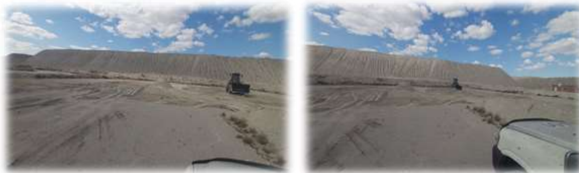
Зураг 19. Уурхайн засвар үйлчилгээний хэсэгт хайрга давхар хийж байгаа байдал талбайг хатуу хучилт хийж хөрсний бохирдлоос хамгаалсан байдал.
