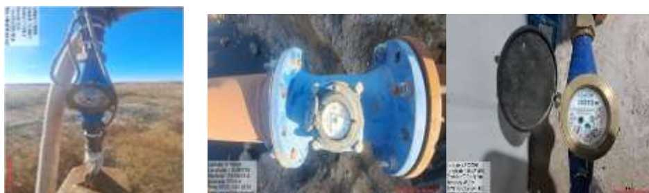
Зураг 7. Хашаатын цав уурхайн шүүрлийн ус, ногоон байгууламжийн усалгааны болон унд-ахуйн зориулалтаар ашигладаг гүний худгуудыг тоолууржуулсан байдал
