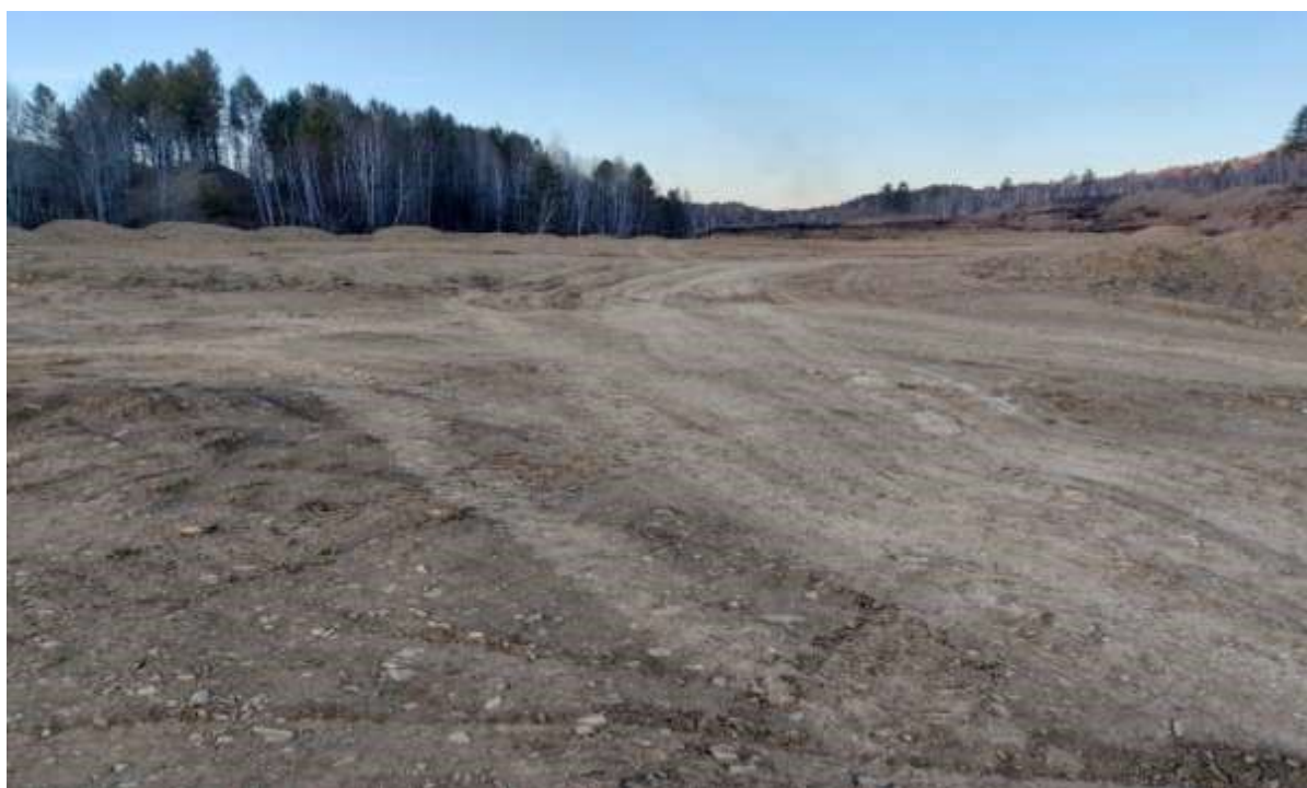
Зураг 8. Дотоод дүүргэлтээр нөхөн сэргээлт хийсэн талбайн байдал
