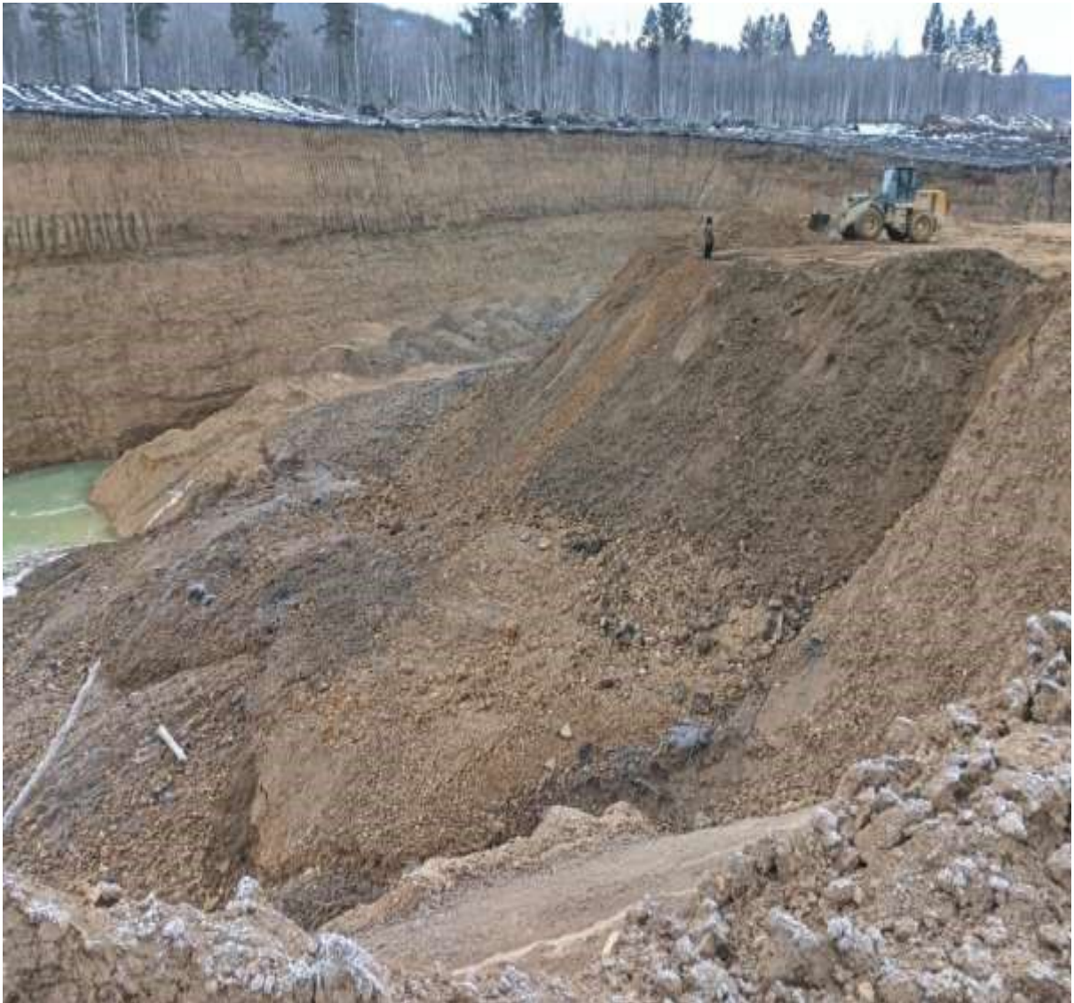
Дотоод овоолгоор дүүргэлт хийгдэж байгаа ажлын явц.
