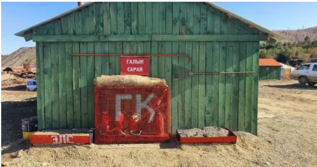
Зураг 14. Гал тогооны байрны хажууд шинээр галын сарай хийж байрлуулсан
