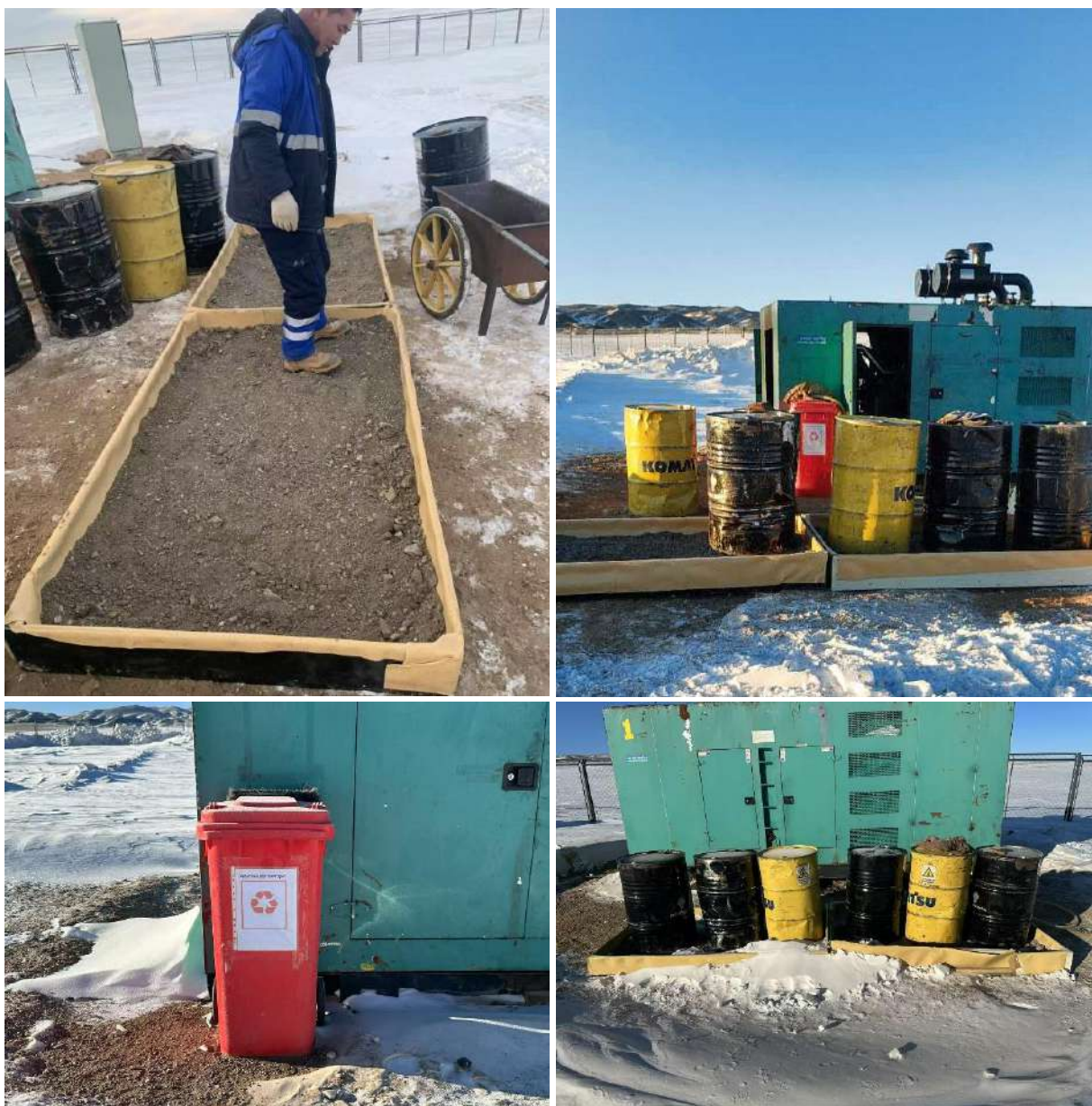
Зураг № 51. Генераторын орчим дахь хөрс бохирдохоос сэргийлсэн байдал
