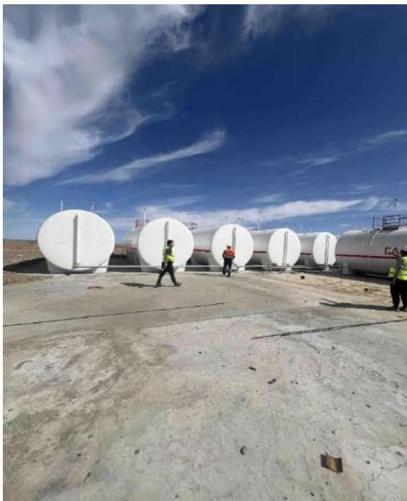
Зураг №10. Шатахуун түгээгүүрийн суурийн ажлын гэрээ, ажлын явц
