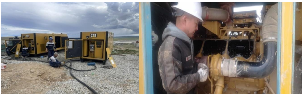
Зураг 6: Техник хэрэгсэлийн үзлэг шалгалт, техник үйлчилгээ хийж буй байдал
