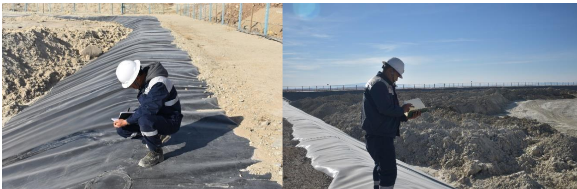
Зураг 29: Хаягдлын даланг шалгаж буй байдал
