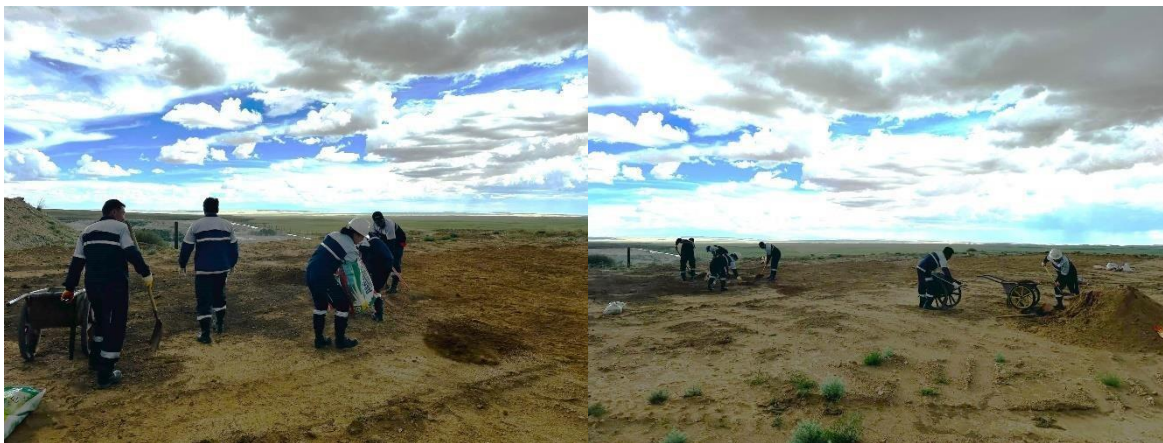
Зураг 22: Жижиг хаягдлын далангийн хөрсийг бордоожуулж, олон наст ургамлын үр цацаж буй байдал
