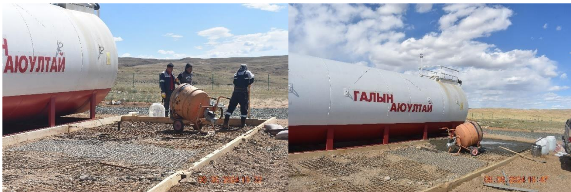
Зураг 13: Зөөврийн танкны суурийг цутгаж буй байдал
