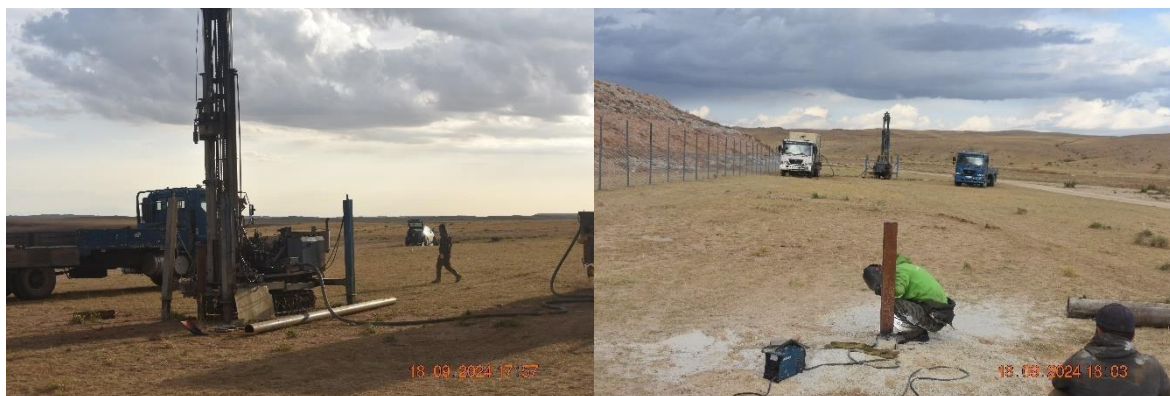
Зураг 9: Шинэ хаягдлын далангийн урд хэсэгт хяналтын цооног гаргаж буй байдал
