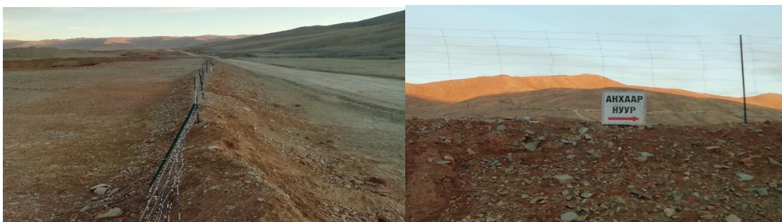
Зураг.16 Үерийн уснаас хамгаалах далан шуудуу, хашаа хамгаалалт хийсэн байдал
