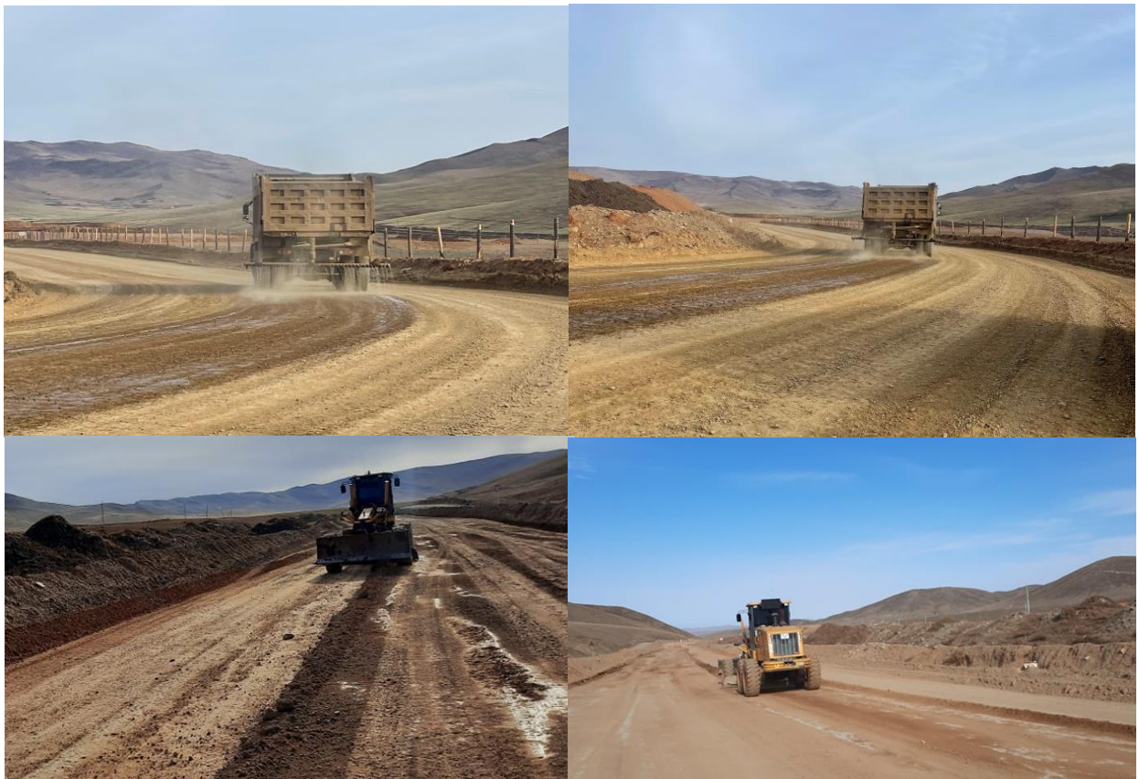
Зураг.1 Тээврийн замд эфелээ дэвсэлт хийж, автогрейдерээр тэгшилэв.
