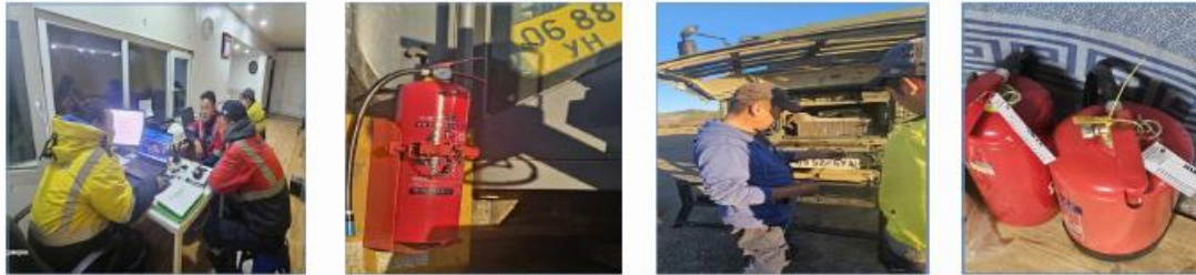
Зураг 28. Гал унтраагуур шалгасан
