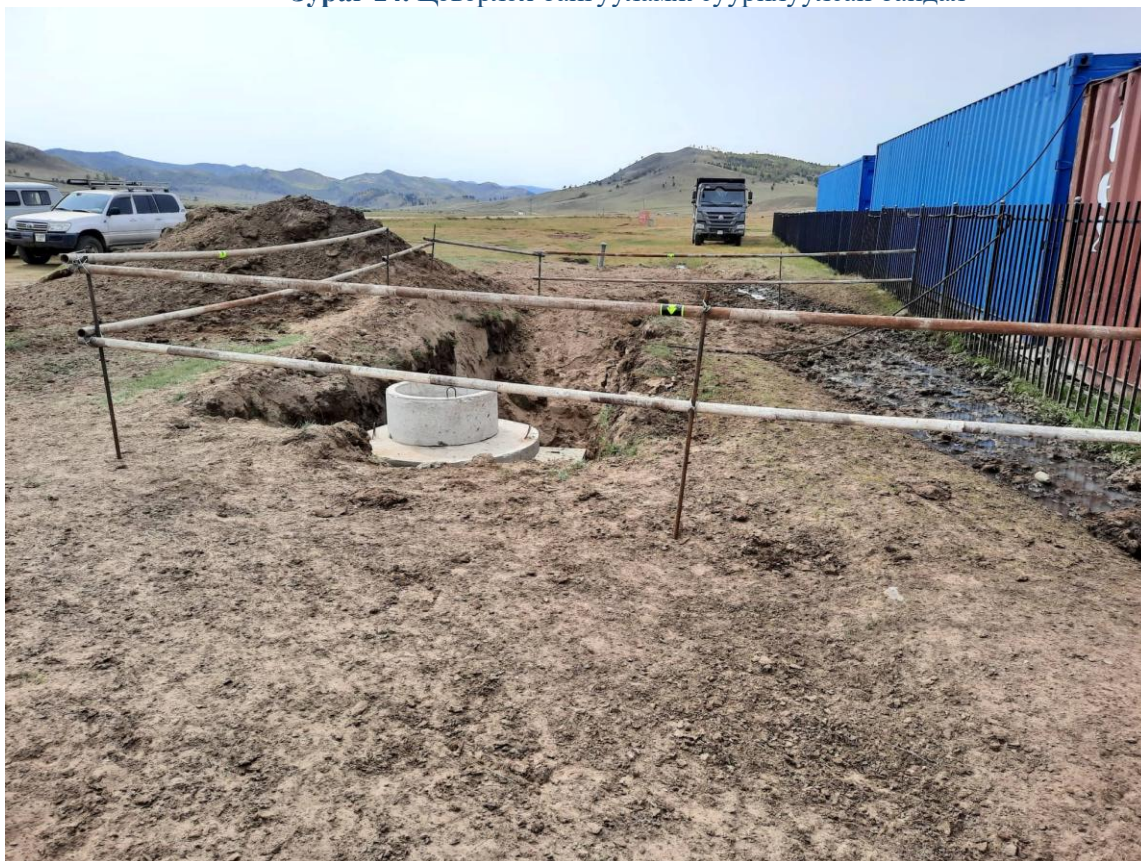
Зураг 14. Цэвэрлэх байгууламж суурилуулсан байдал
