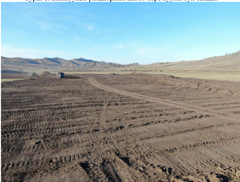
Зураг 3. Баяжуулах үйлдвэрийн шимт хөрс хуулж буй байдал
