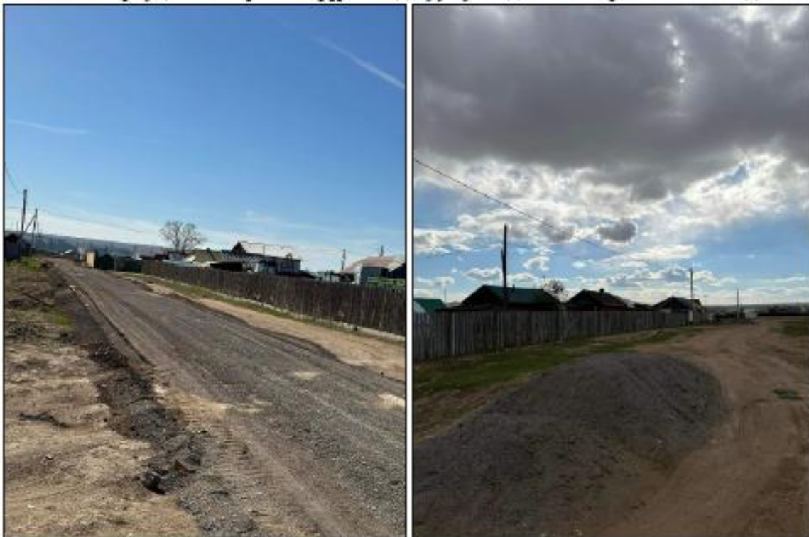
Автогрейдэрээр 600м гудамжны замын дэвсгэлтийн материал түрж өгөв.
