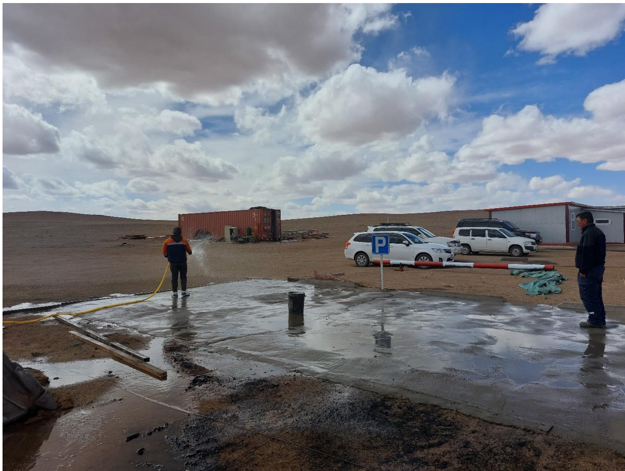
Зураг 7. Тоосжилт бууруулах усалгаа хийгдэж буй байдал
