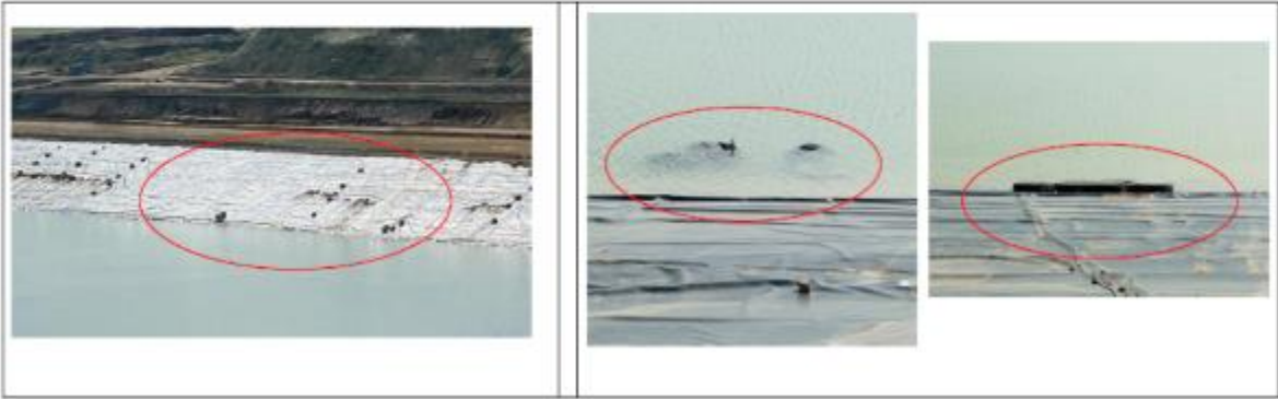
Зураг 2. Далангийн хулдвасны хүндрүүлэгч дугуй зүтэнд унасан байдал
