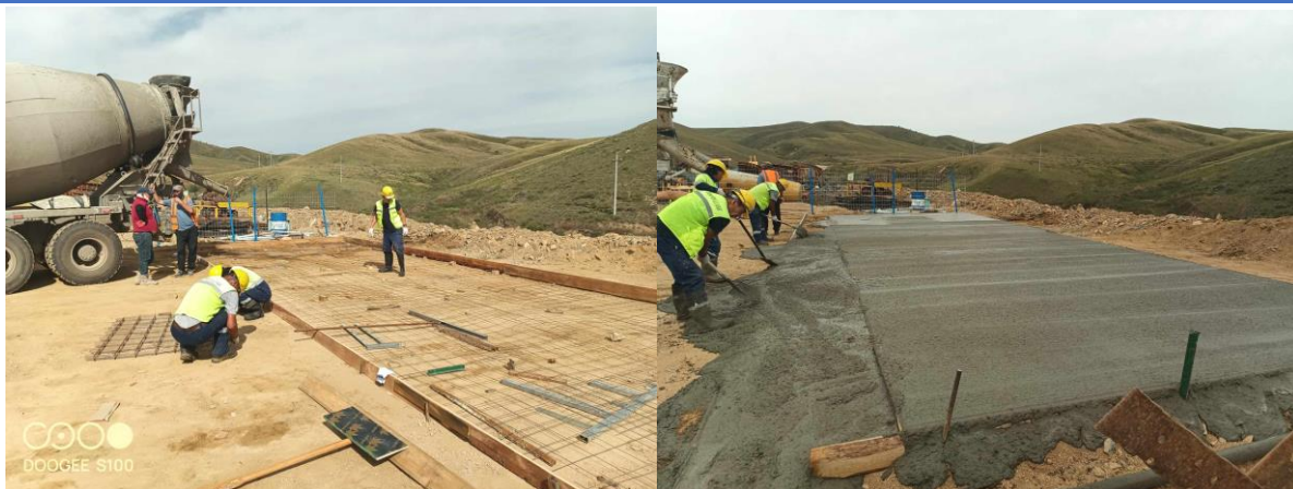
Зураг 135. Аюултай хог хаягдлын цэгийг цементэн хучилттай болгов
