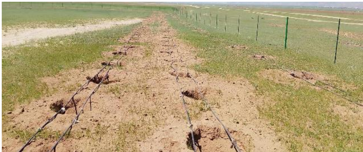
Зураг 73. Дуслын усалгааны систем байршуулсан байдал
