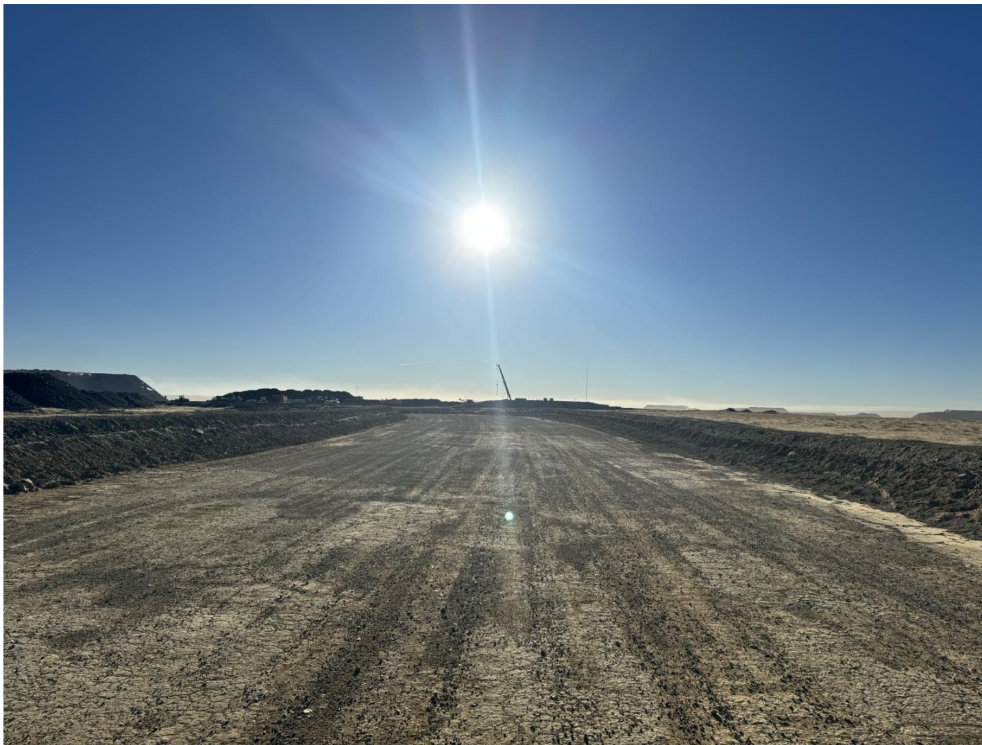
Зураг 7. Дотоод тээврийн замыг засаж сайжруулсан, замын 2 талаар хөмсөг татсан.
