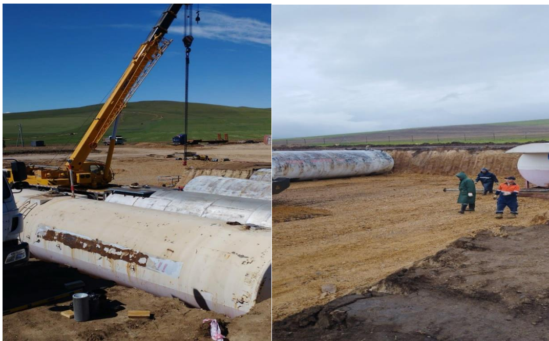
Зураг.6 Шатхуун хадгалах агуулахын талбайг хайрган хучилт хийж байрлуулсан / Ажил эхлэхийн өмнө /
