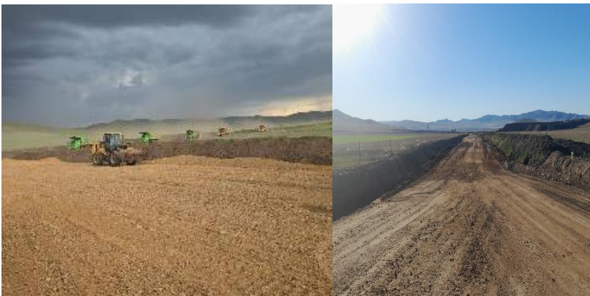
Зураг.1 Нийт 5.5 км тээврийн замуудын шимт хөрсийг хуулж хайрган хучилт хийж ажиллаа. / Ажил эхлэхийн өмнө 6 сар /
