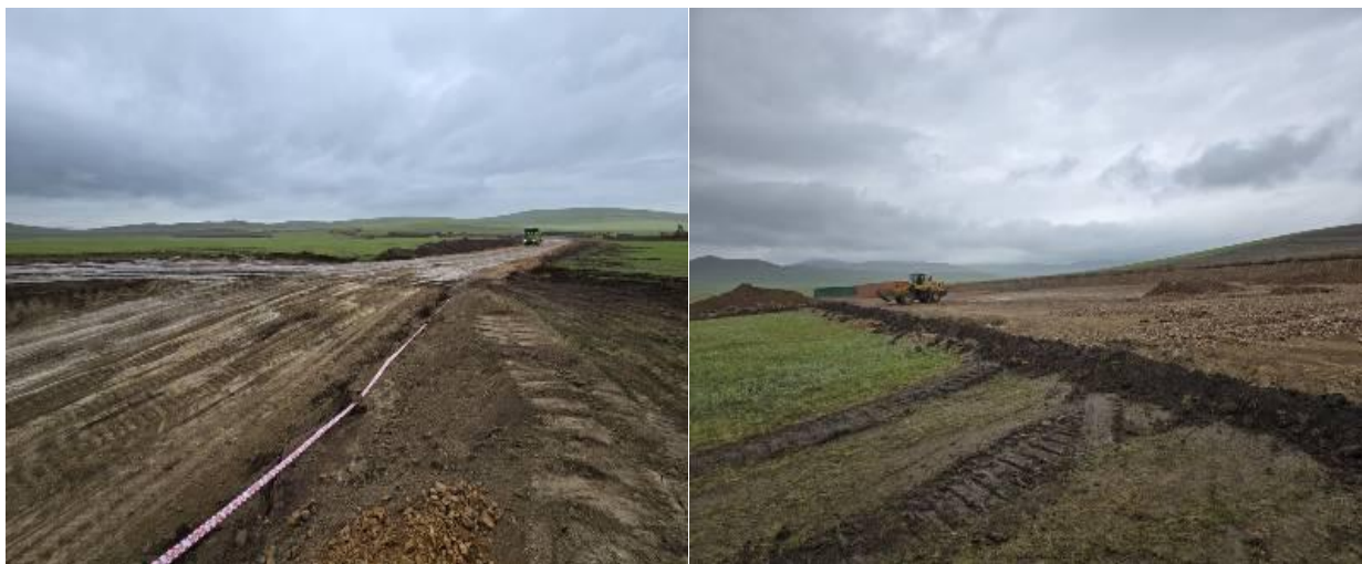
Зураг.1 Нийт 5.5 км тээврийн замуудын шимт хөрсийг хуулж хайрган хучилт хийж ажиллаа. / Ажил эхлэхийн өмнө 6 сар /
