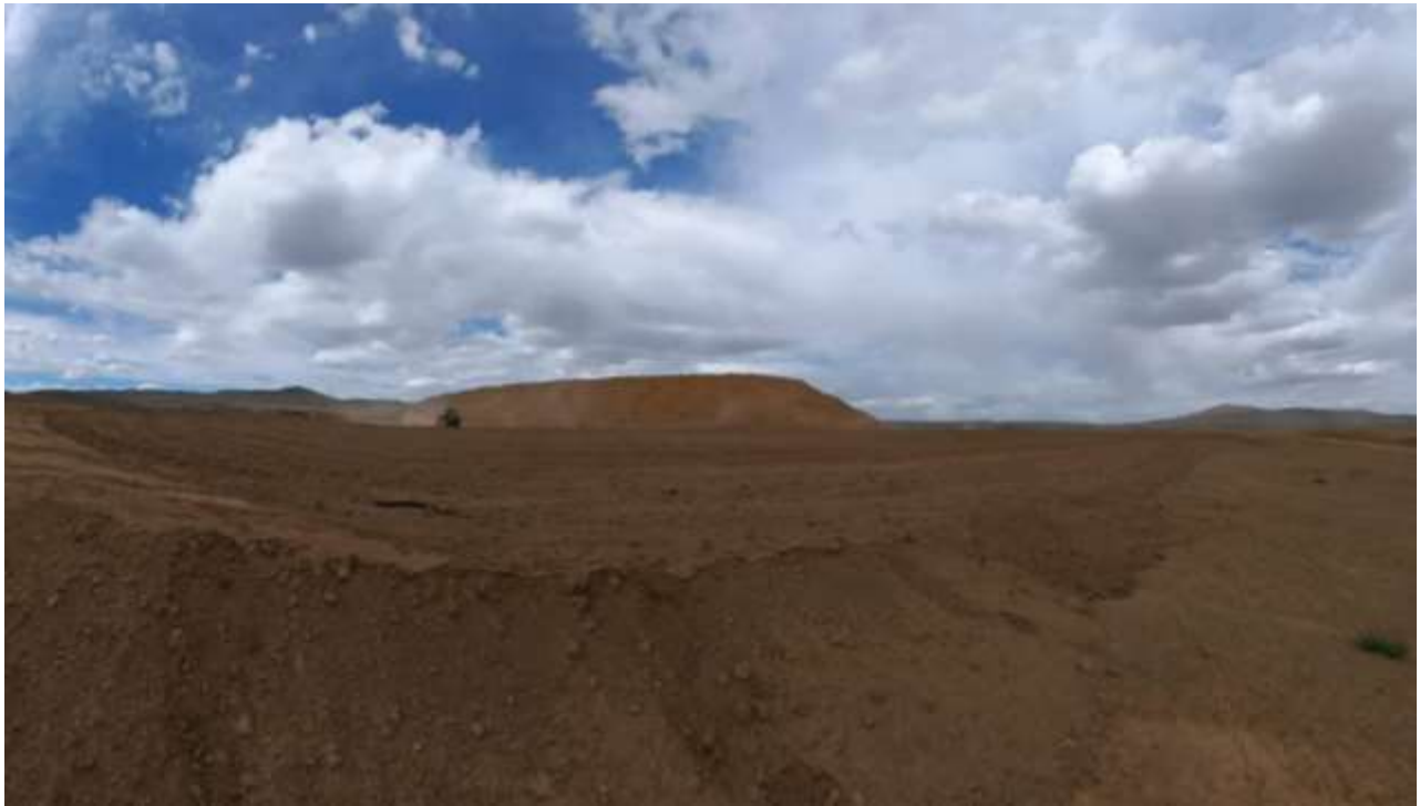
Зураг 14 Шимт хөрсний хучилтын ажил буюу Шимт хөрс дэвссэн байдал
