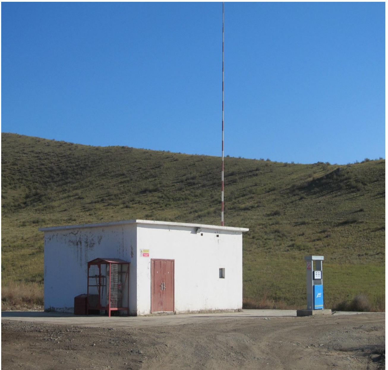
Зураг 18. Шатахуун түгээх станц
