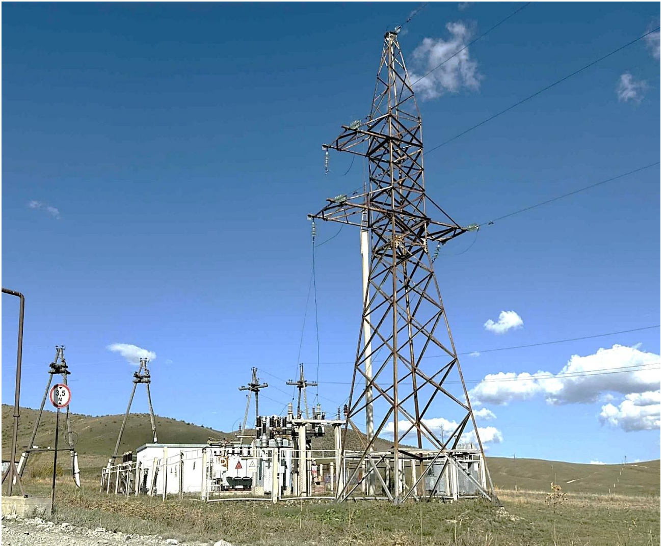
Зураг 9. Уурхайн дэд станц оролтын шугамын хүчин чадал (35000V)
