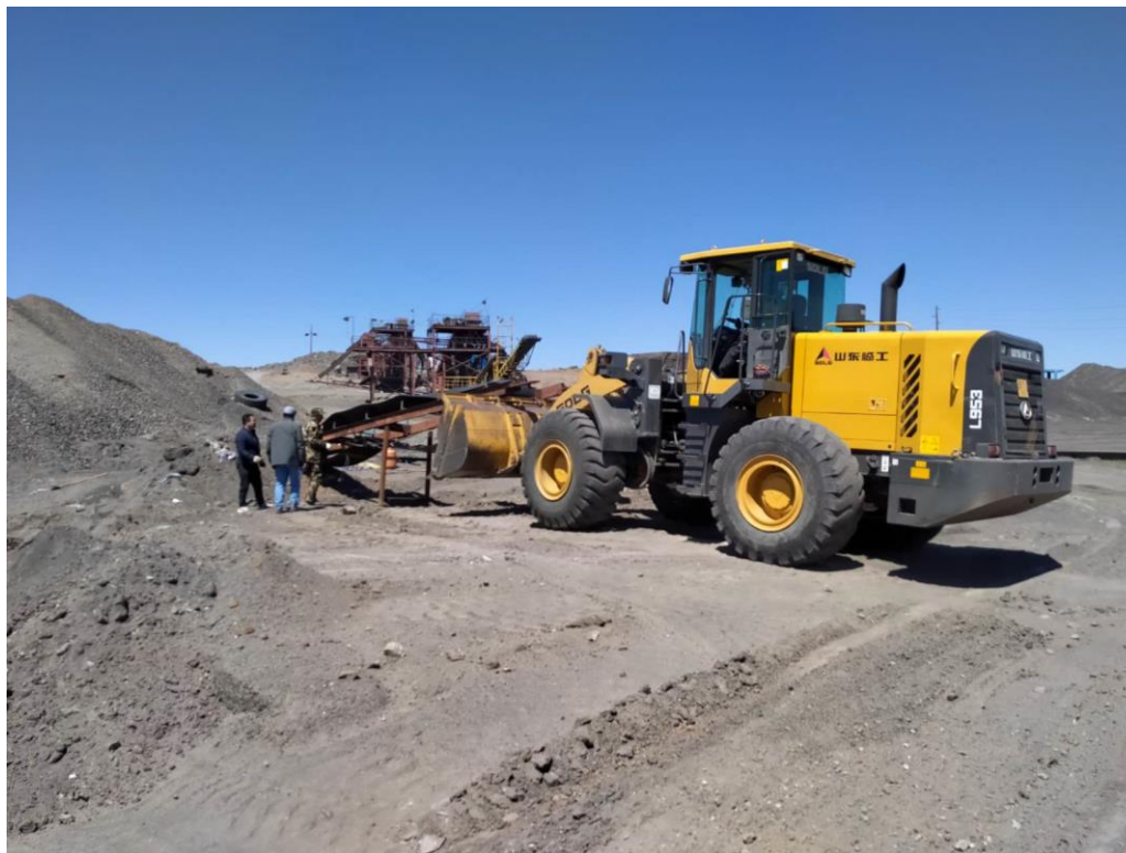
Зураг.7. Илүү ашиглалт явуулсан газраас тоног төхөөрөмж шилжүүлж буй зураг, 2023-09-08
