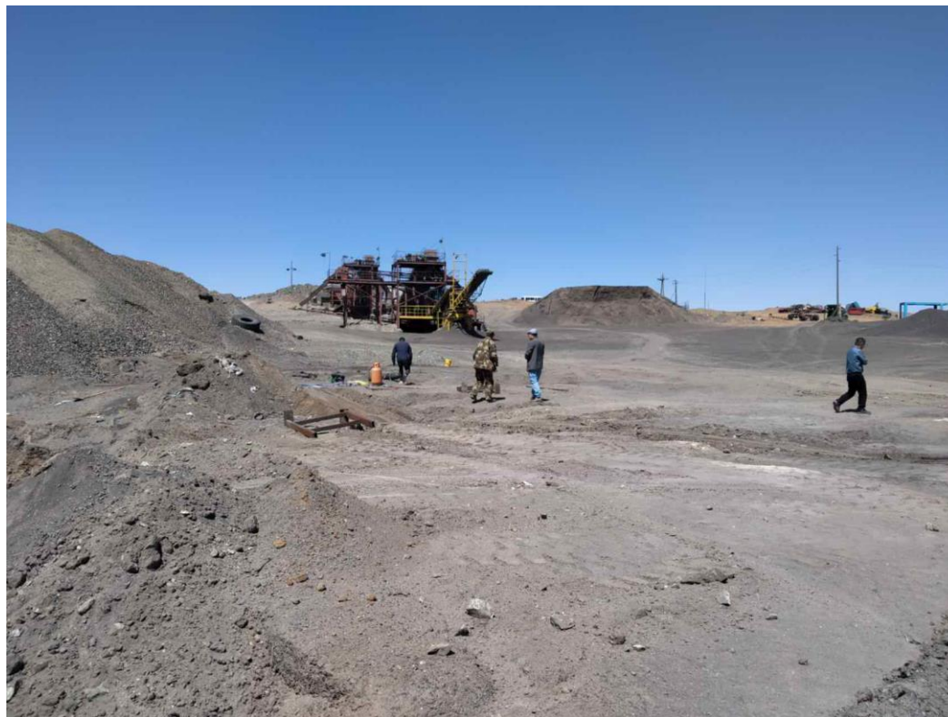
Зураг.9. Илүү ашиглалт явуулсан газраас тоног төхөөрөмж шилжүүлж буй зураг, 2023-09-08
