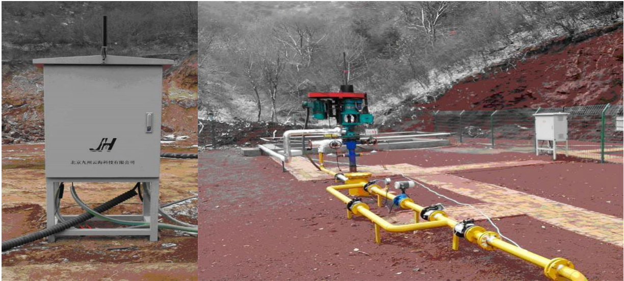
Зураг 8. Хийн шугам (шар хоолой) болон (саарал хоолой)-г шавхалтын ус түр хуримтлуулах сантай холбосон байдал
