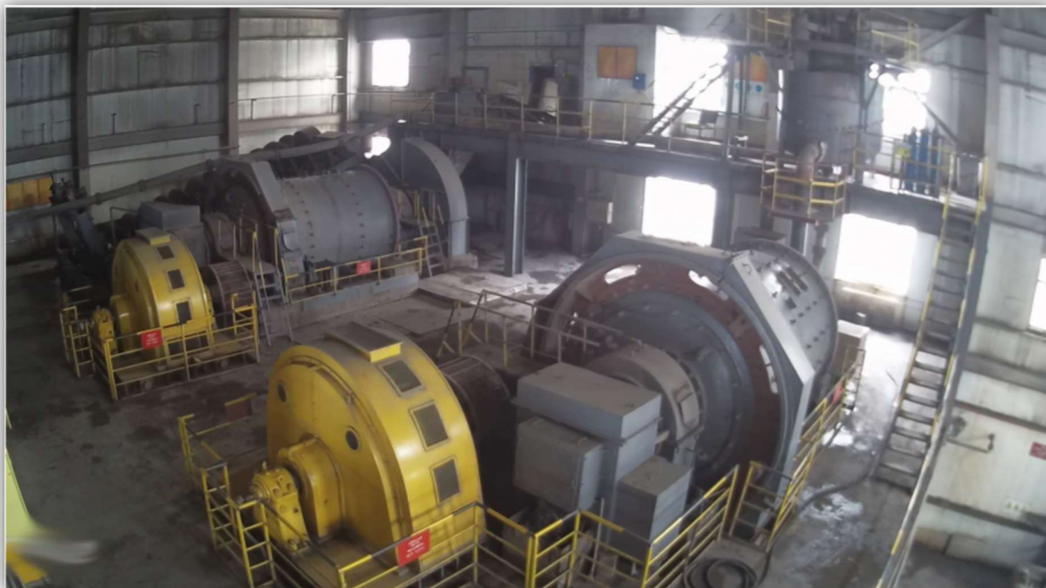
Зураг.2 Баяжуулах үйлдвэр тээрмийн цех
