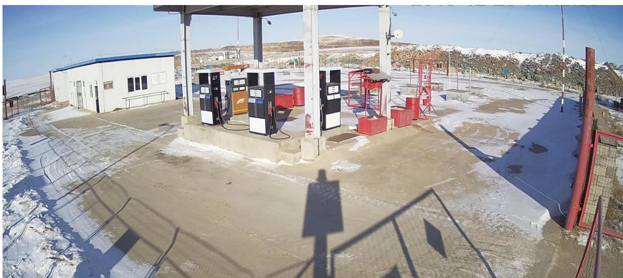
Зураг.3 Шатахуун түгээх станц
