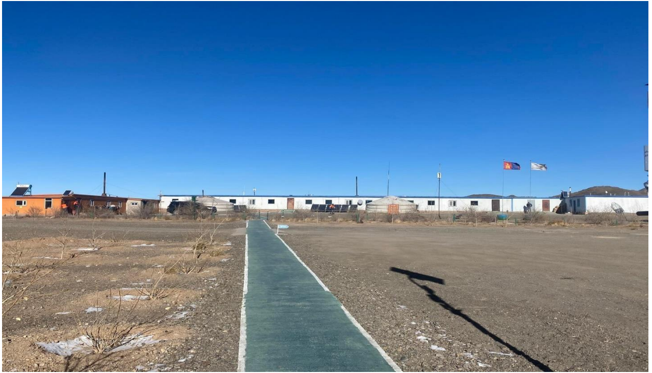
Зураг 8 Барилга байгууламж
