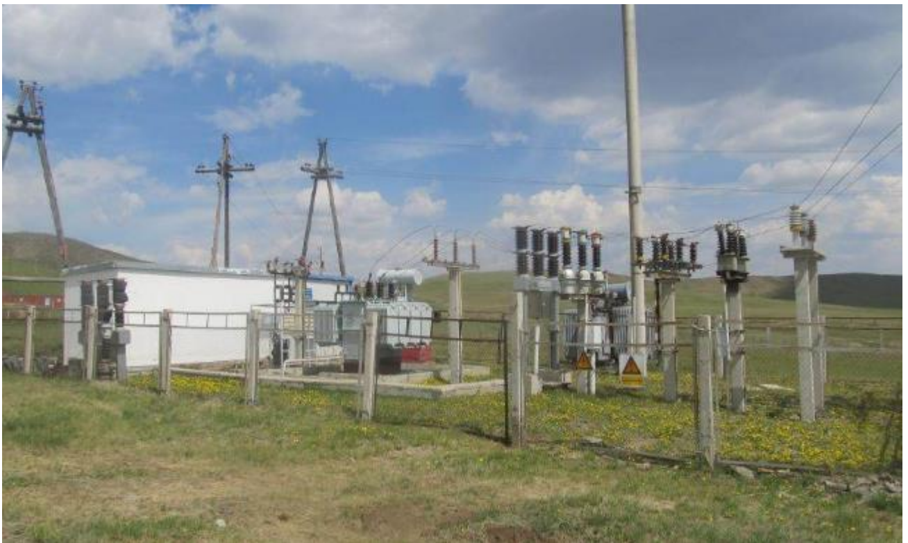
Зураг 10. Уурхайн дэд станц оролтын шугамын хүчин чадал (35000V)
