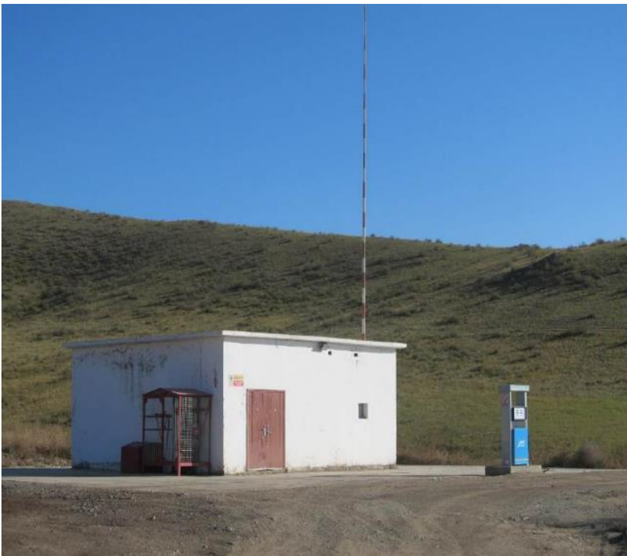
Зураг 18. Шатахуун түгээх станц
