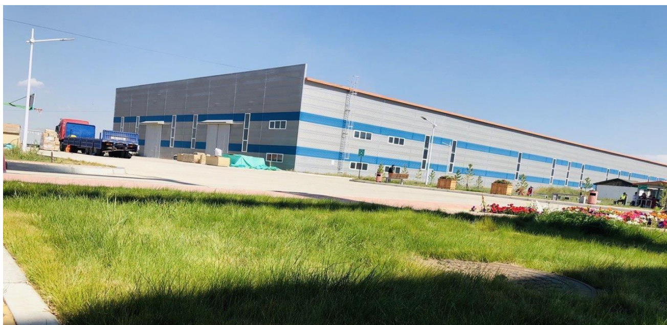
Зураг- 2. Агуулах байрлах сендвичэн барилга
