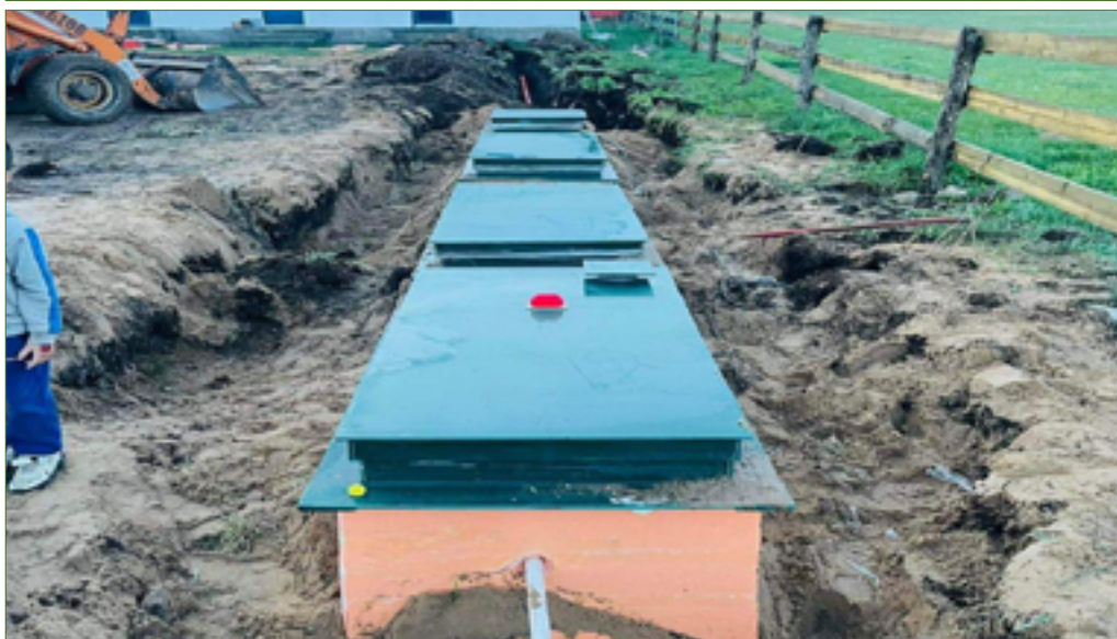
Бохир ус цэвэрлэх станц суурилуулах үеийн зурагнууд
