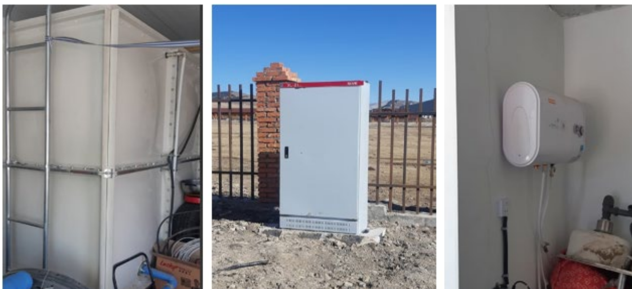
Зураг 2. Усны нөөцийн сав, Цахилгаан тоолуурын самбар, Ус халаагч бойлероор шийднэ
