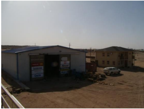
Зураг 2. Засвар үйлчилгээний барилга болон ажилчдын байр
