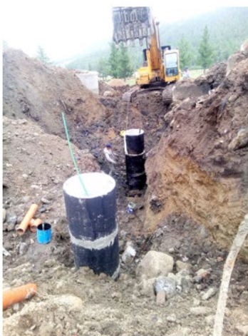
Бүх хүзүү хоолойг битүмдэж хөрсний ус нэвчилтээс хамгаалсан.
