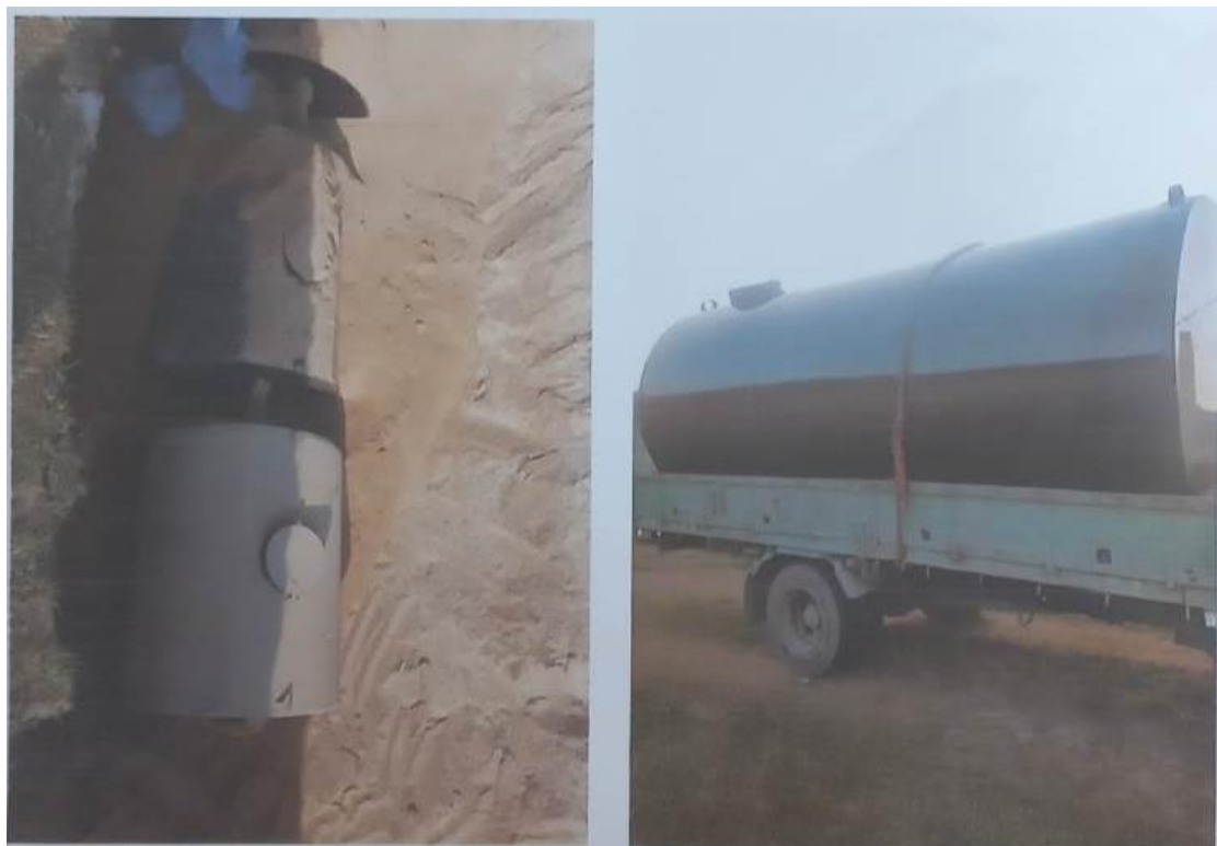
Зураг 7. Цэвэрлэх байгууламж хийж буй зураг
