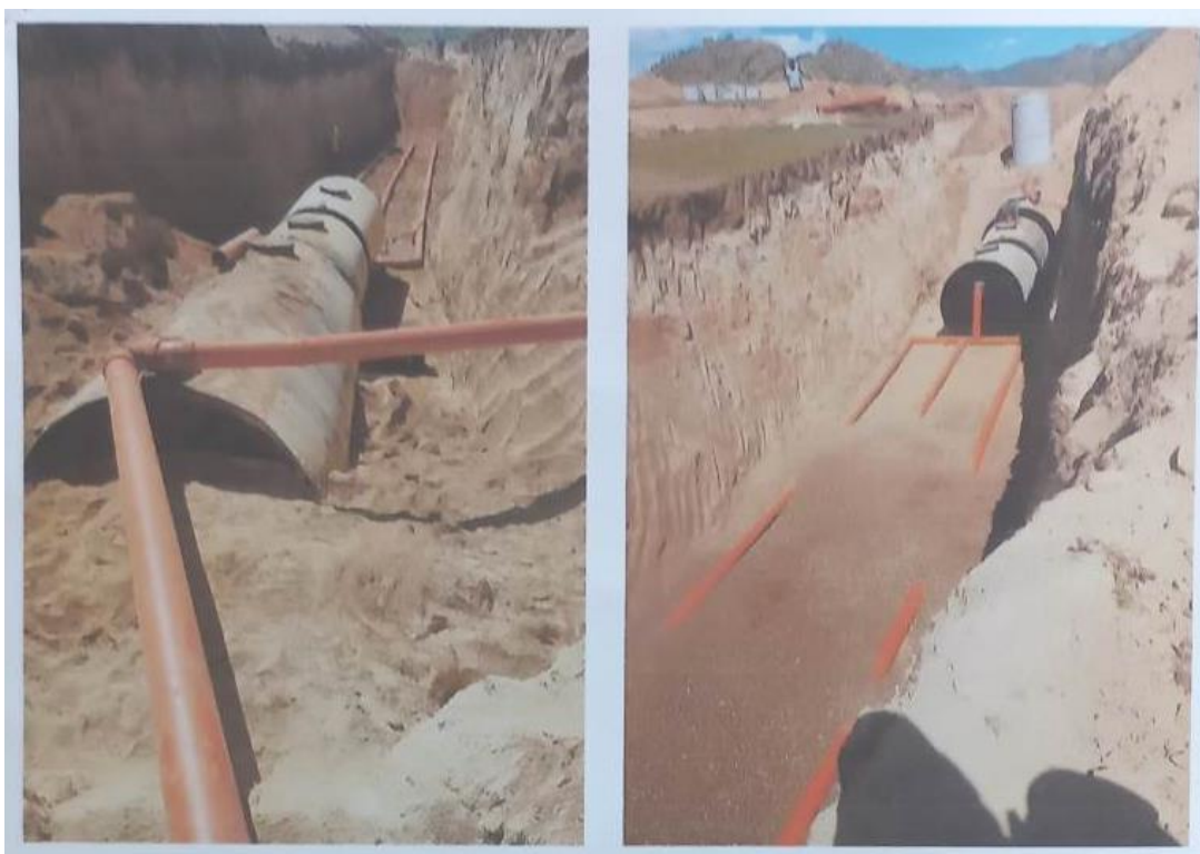
Зураг 6. Бохир усны систем суурилж буй зураг
