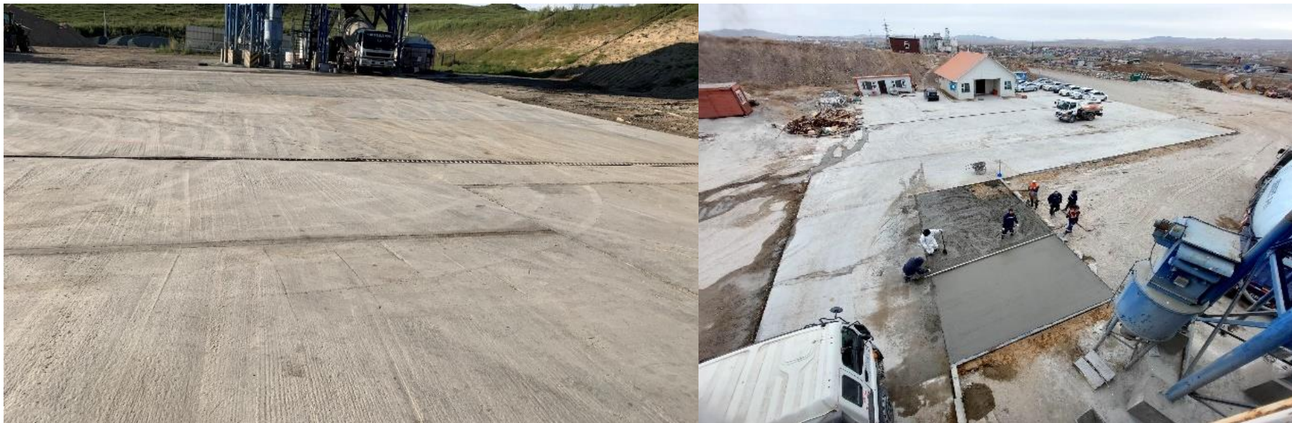
Зураг 6. Үйлдвэрийн технологийн талбайг бетондож буй байдал
