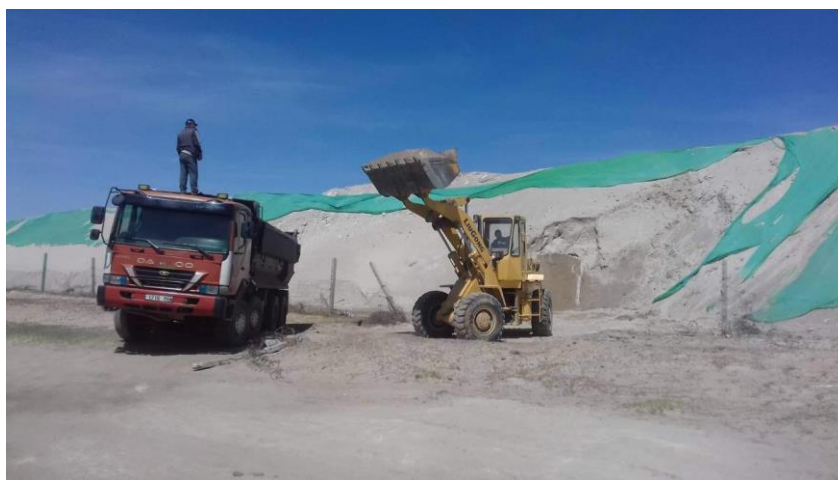
Зураг 12. Үнс хадгалах талбайн хучлагыг түр үнс ачиж буй байдал
