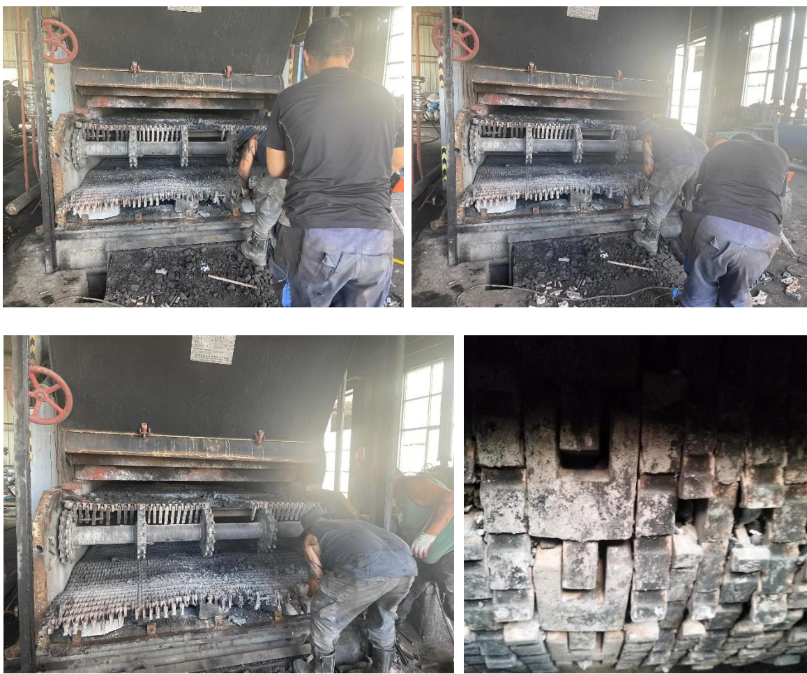
Зураг 8. Уурын зуухны үнсийг цэвэрлэх, ээлжит засвар үйлчилгээ хийж буй байдал
