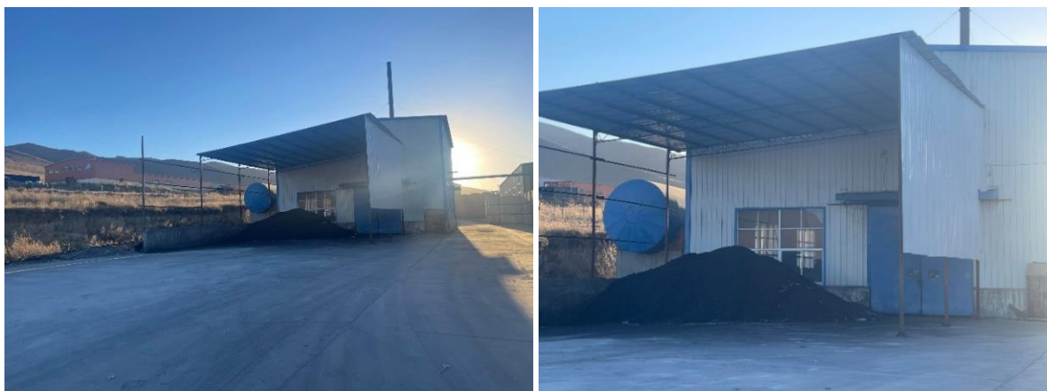
Зураг 11. Үйлвэрийн талбай дахь задгай түүхий эд хадгалах хэсэгт саравч байгуулсан нь
