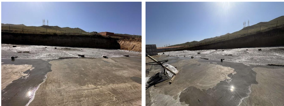
Зураг 9. Тоосжилттой үед үйлдвэрийн орчныг усалж чийгшүүлсэн байдал
