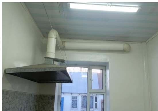
Үйлдвэрийн байланд агааржуулалт суурилуулсан байдал
