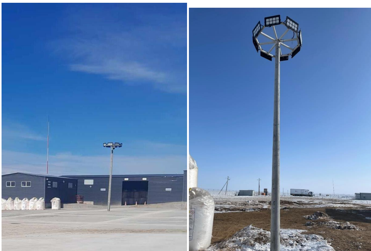
Зураг 37. Үйлдвэрийн талбайд гэрэлтүүлэг хийсэн байдал
