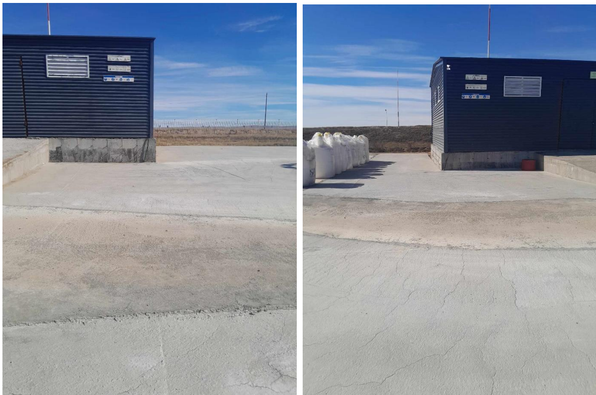
Зураг 16. Тэсрэх бодисын үйлдвэр агуулахын цогцолборт 2000кв.метр талбайг бетондсон байдал
