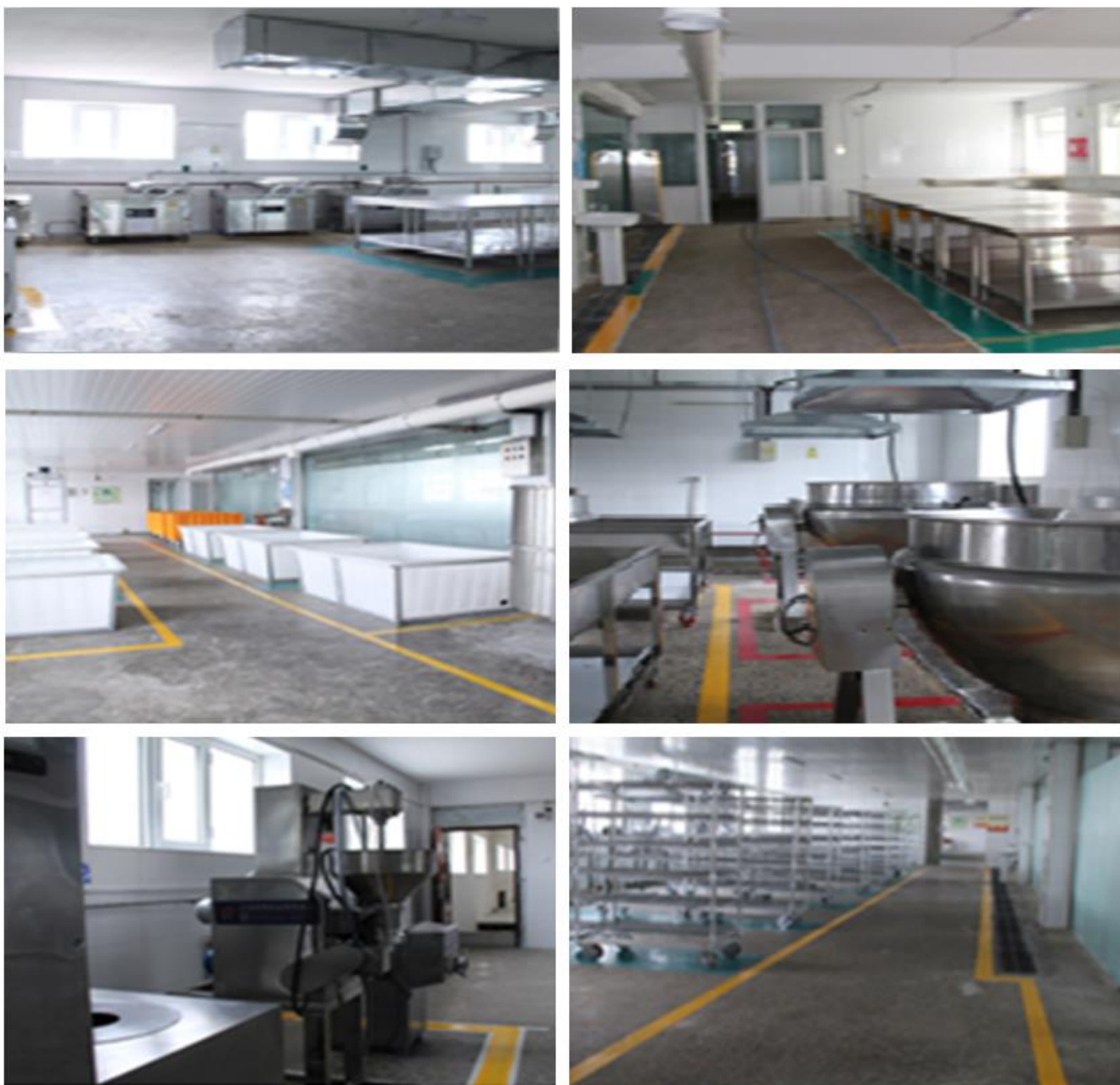
Зураг 4. Үйлдвэрийн тоног төхөөрөмж, дотоод зохийн байгуулалт
