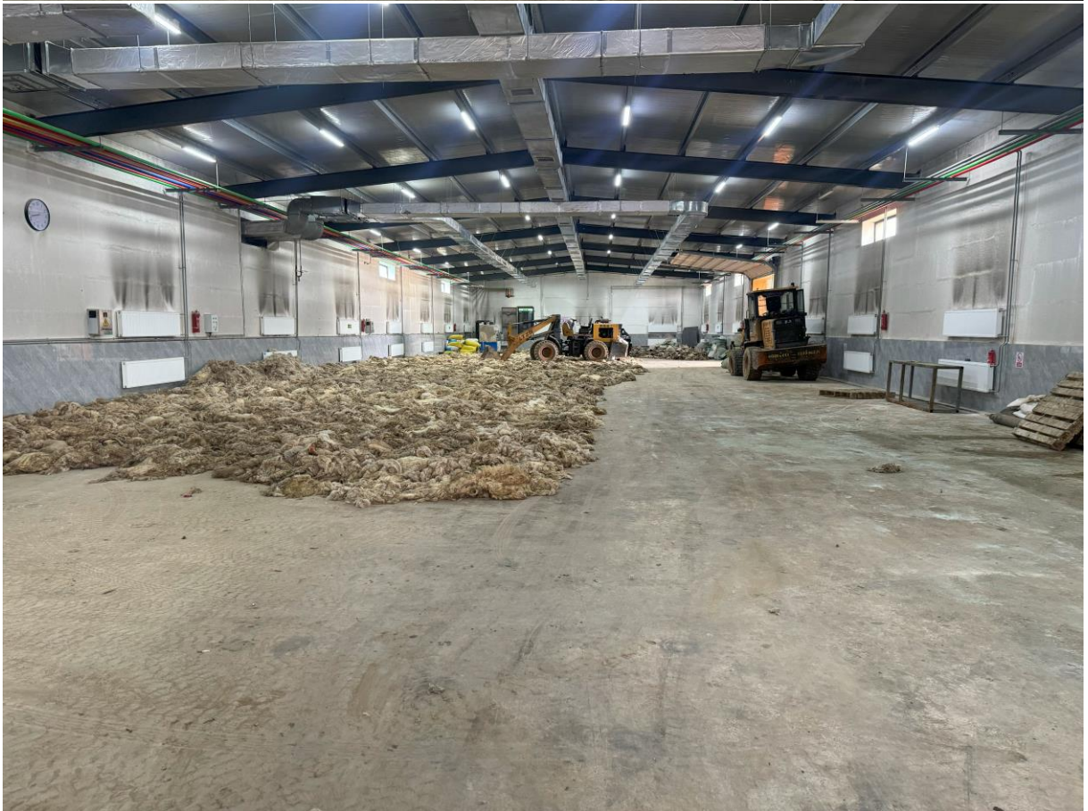
Үйлдвэрийн тоног төхөөрөмж угсралтын ажлын явц болон үйлдвэрийн дотоод зохион байгуулалт
