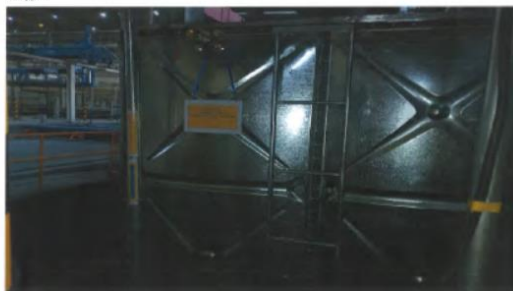
ЗУРАГ 2. Конденсацийн түүхий (Боловсруулаагүй) усны нөөцийн 10м³ сав угсарч суурилуулсан байдал.
