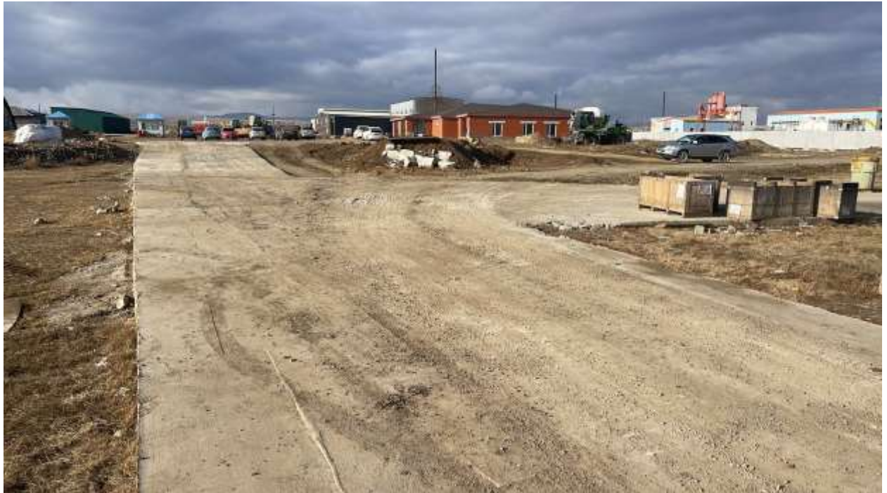
Зураг 3 Агуулах хүртлэх замыг бетонжуулж хатуу хучилттай болгосон.
