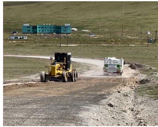
Зураг.7 Усалгаа хийж буй байдал
