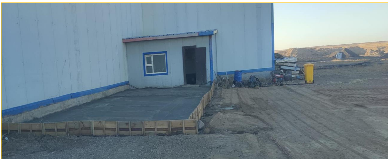
Зураг 15. Засварын талбайг бетондсон байдал
