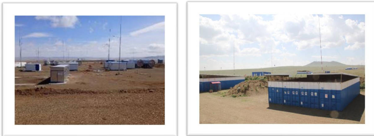
Зураг 12. Үйлдвэр агуулахын цогцолбор харагдах байдал
