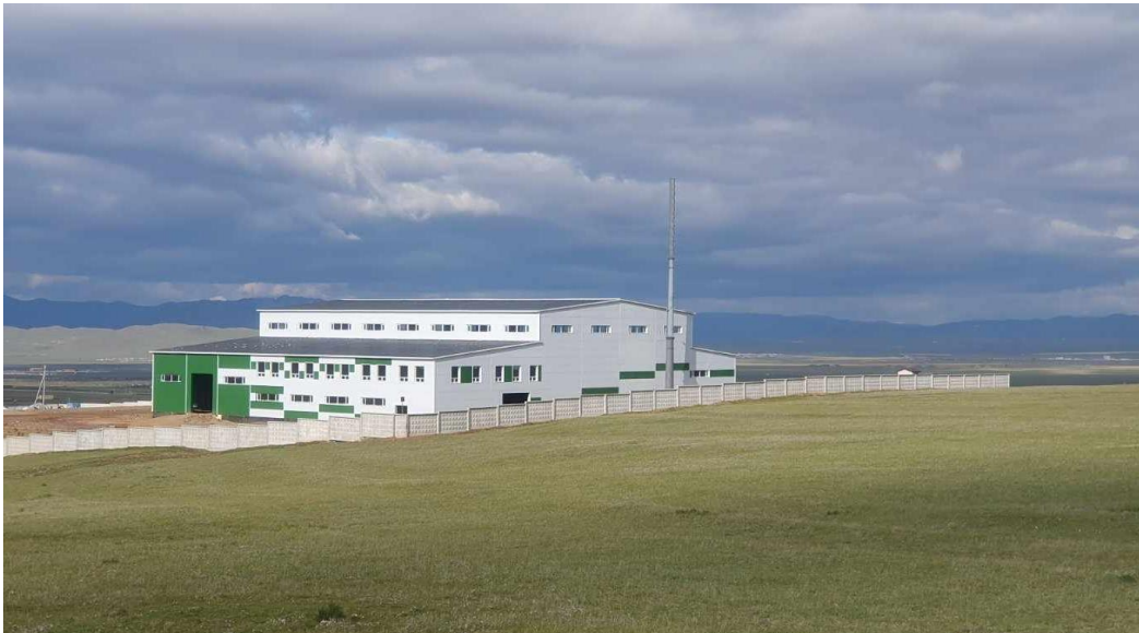
Зураг 1. Үйлдвэрийн барилга баригдаж буй байдал
